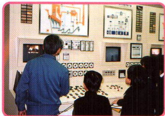
中央せいぎょ室
