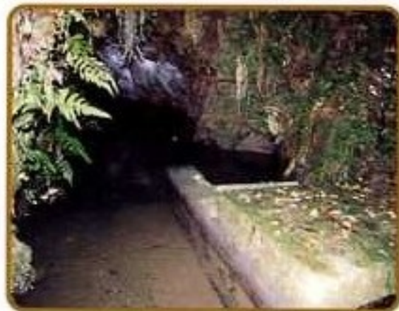
堀越水路すい道（入口）
