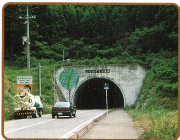
ふくふくトンネル
