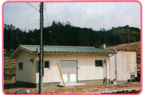
浄水場 着水池
