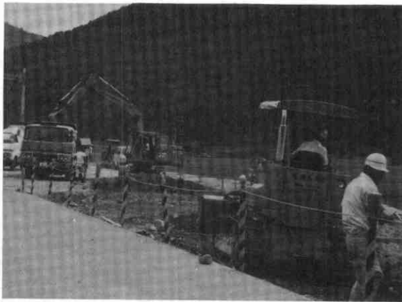
道路工事風景
