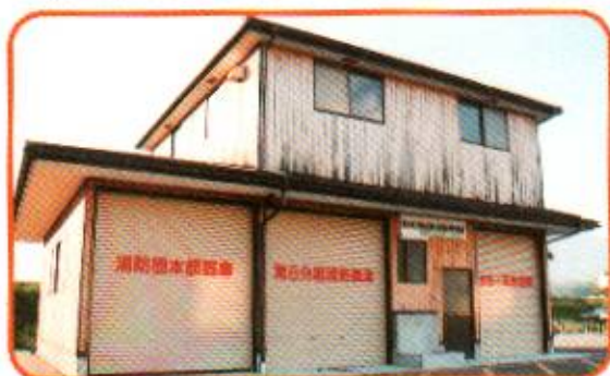
消防車の倉庫
