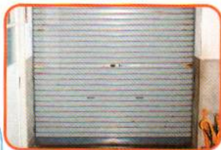
防火シャッター
