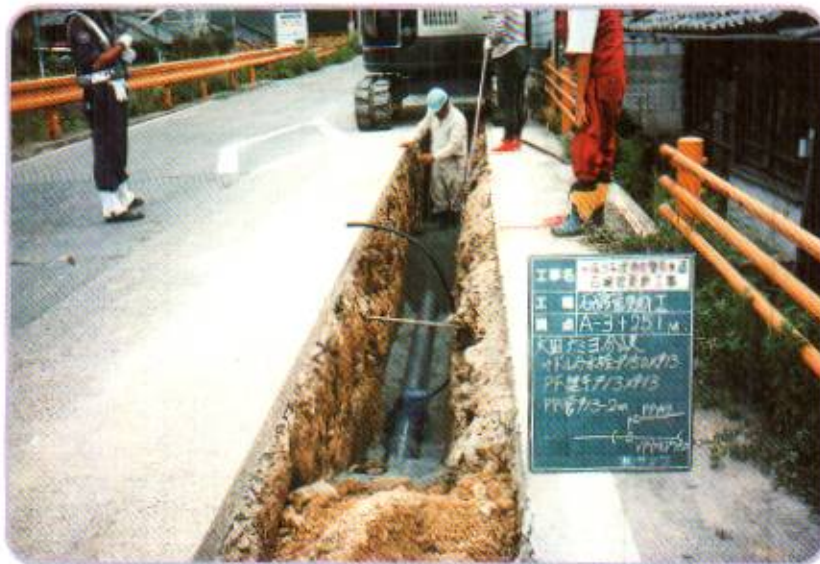
水道管をうめる工事
