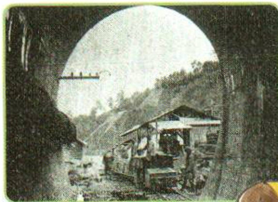
トンネル工事の様子
