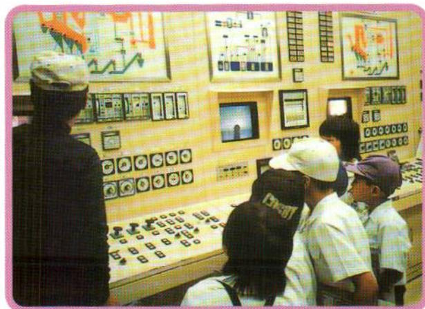
中央せいぎよ室
