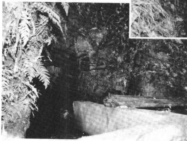
堀越水路隧道
