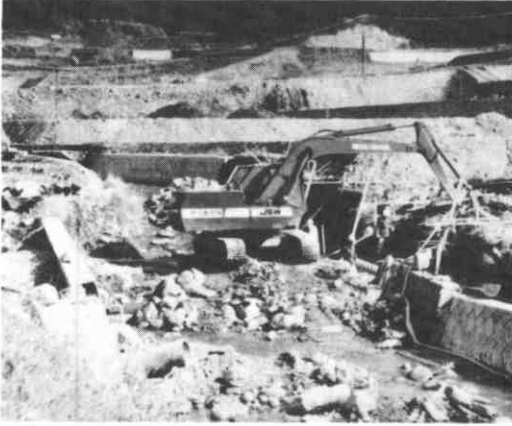
河川改修工事
