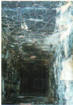
西側の煙突内部（下から上を見る）
