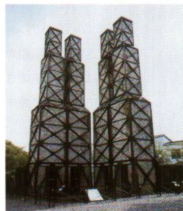
葦山反射炉の現況 平成元年(1989)3月に保存修理工事が終了した 佐賀県立博物館発行 近代化の軌跡より
