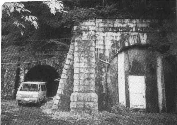
鉄道記念物の逢坂山トンネル東口
