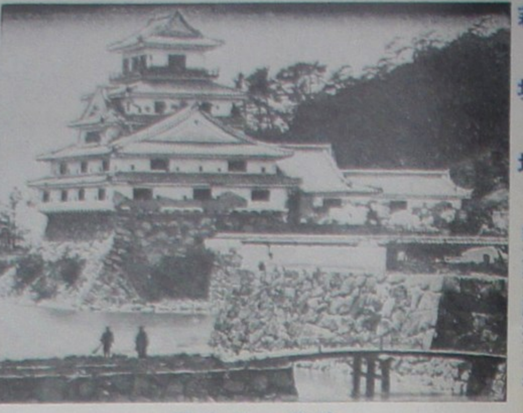
萩城の解体前
