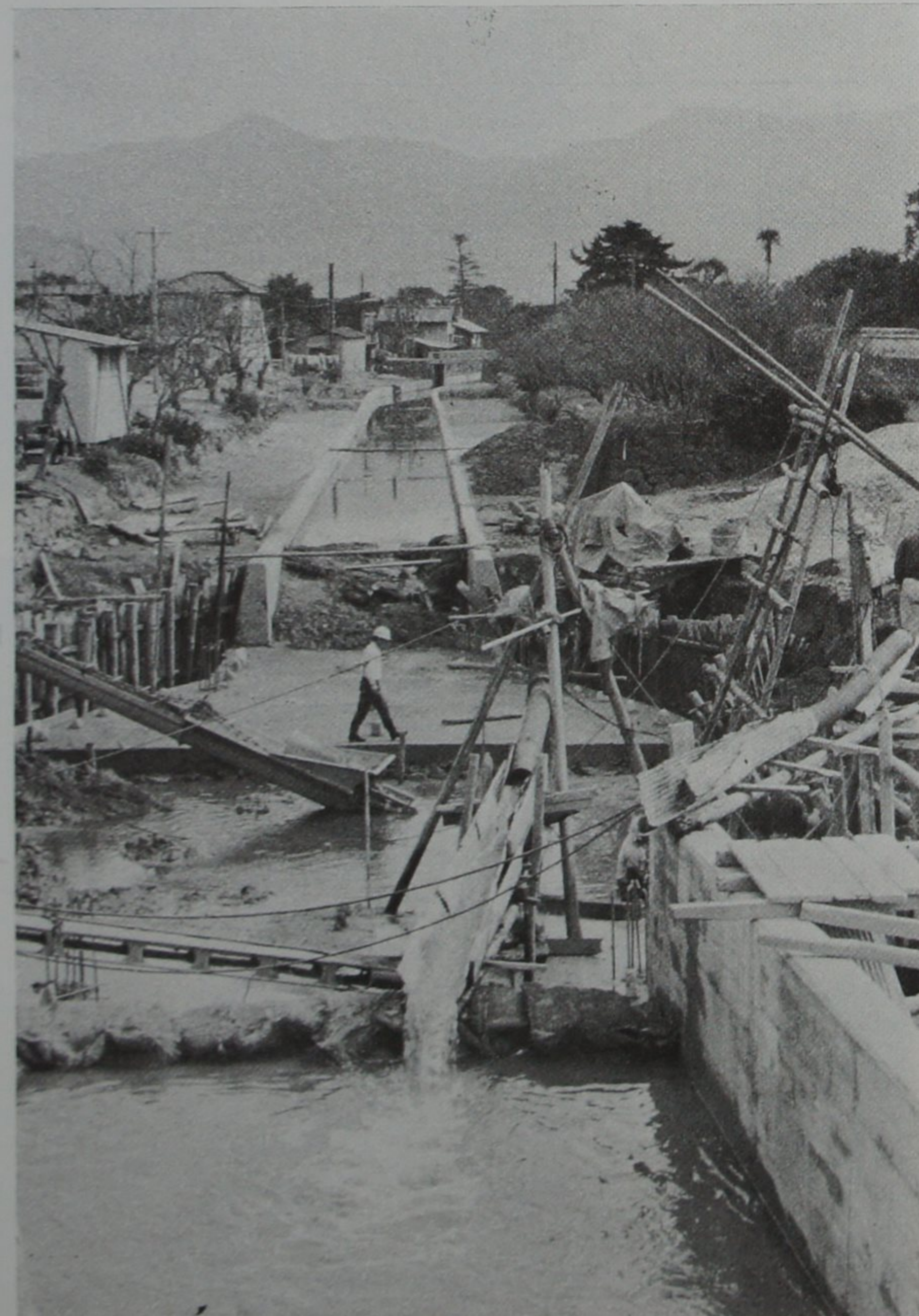
新堀川浚渫工事
