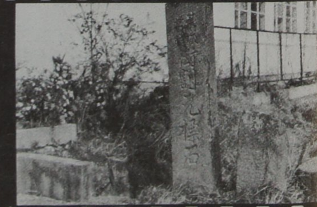
萩城下街割原標石（江向） （1608年） 萩城下は三角洲上に沼や芦原を さけて、武家屋敷、町屋敷をつく ったが、街割の中心になったのは この石である。
