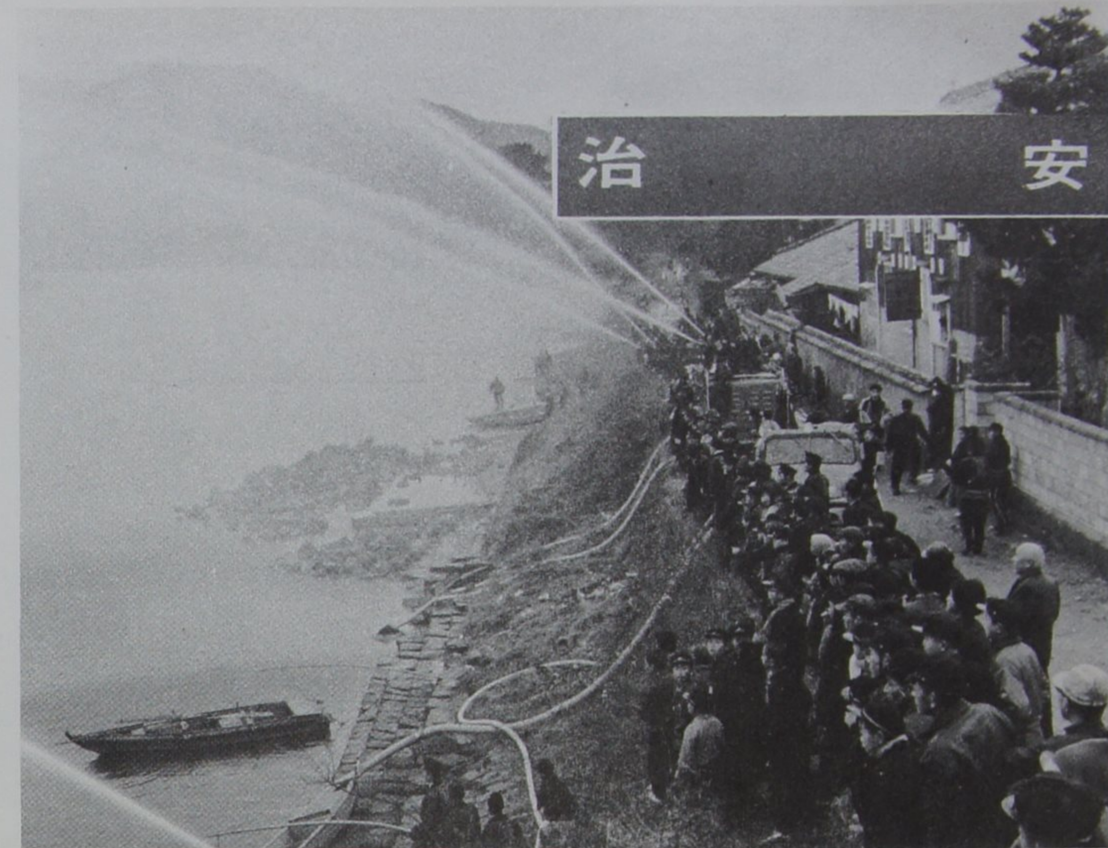
消防団の放水訓練(橋本川にて)
