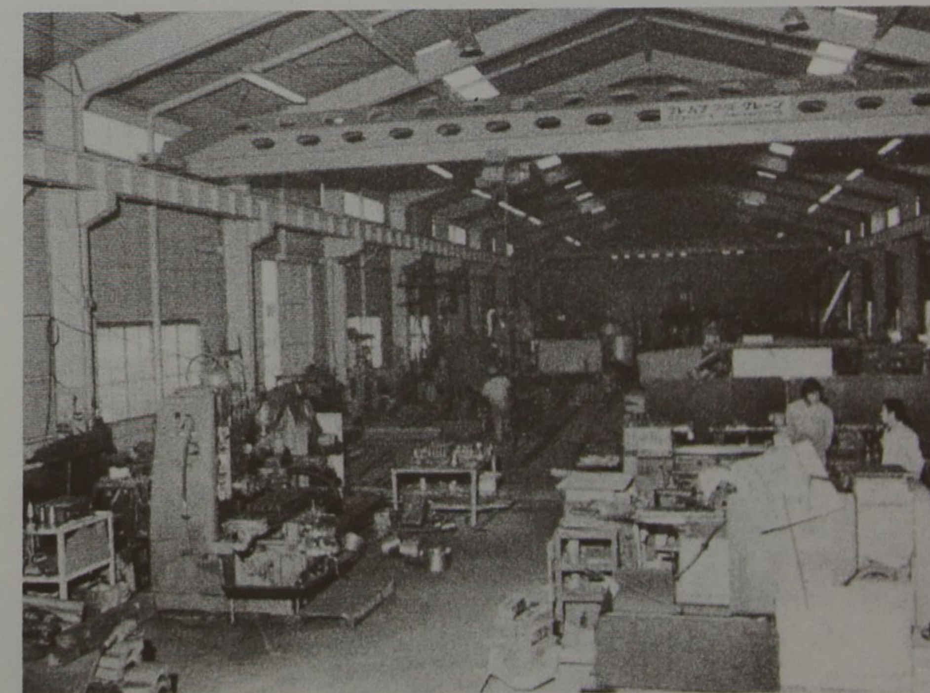
鉄工センター内部
