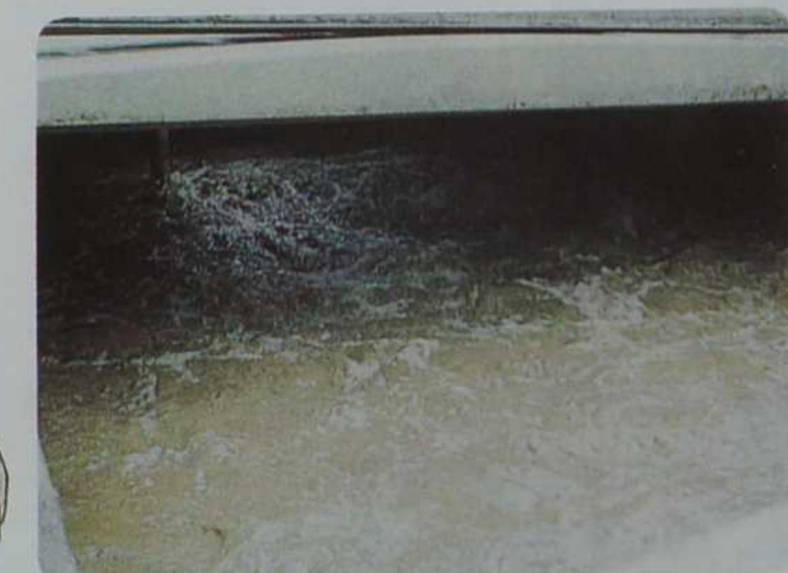
エアレーションタンク
