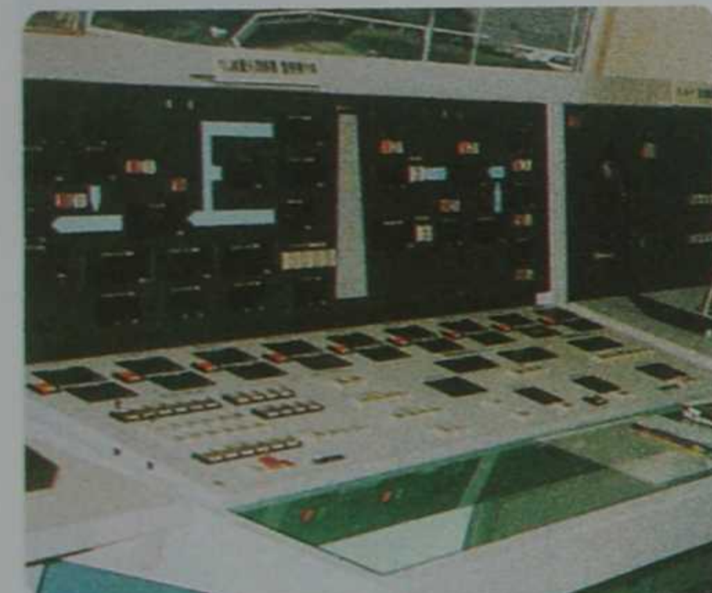
ダムかん理事む所のテレメーター室
