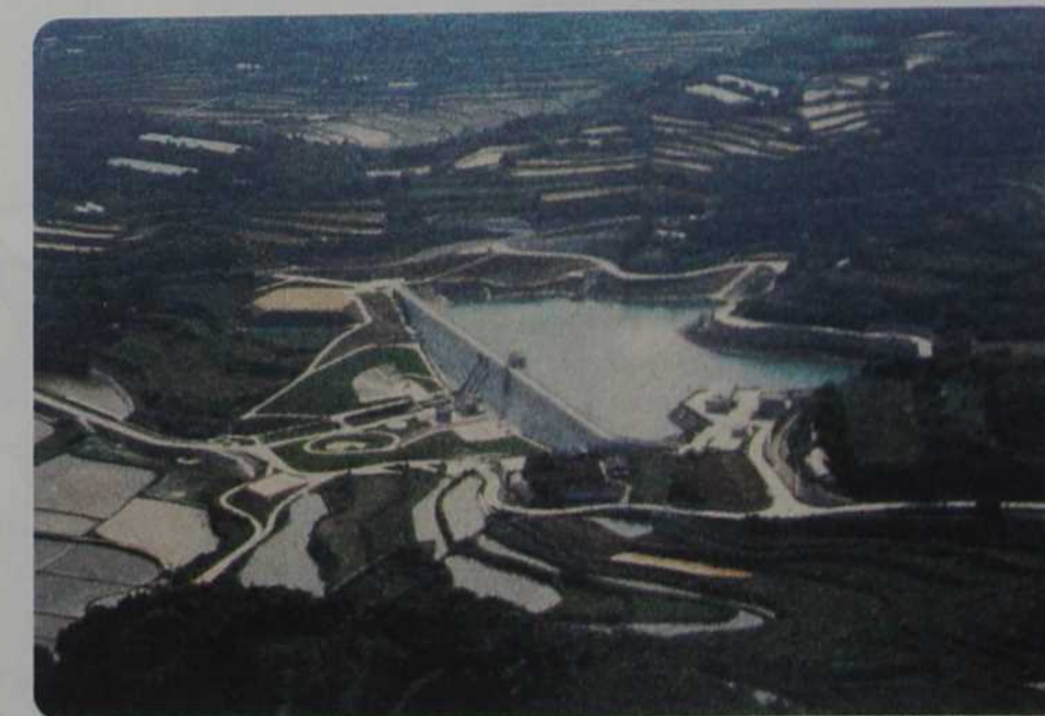
見島ダム (見島)
