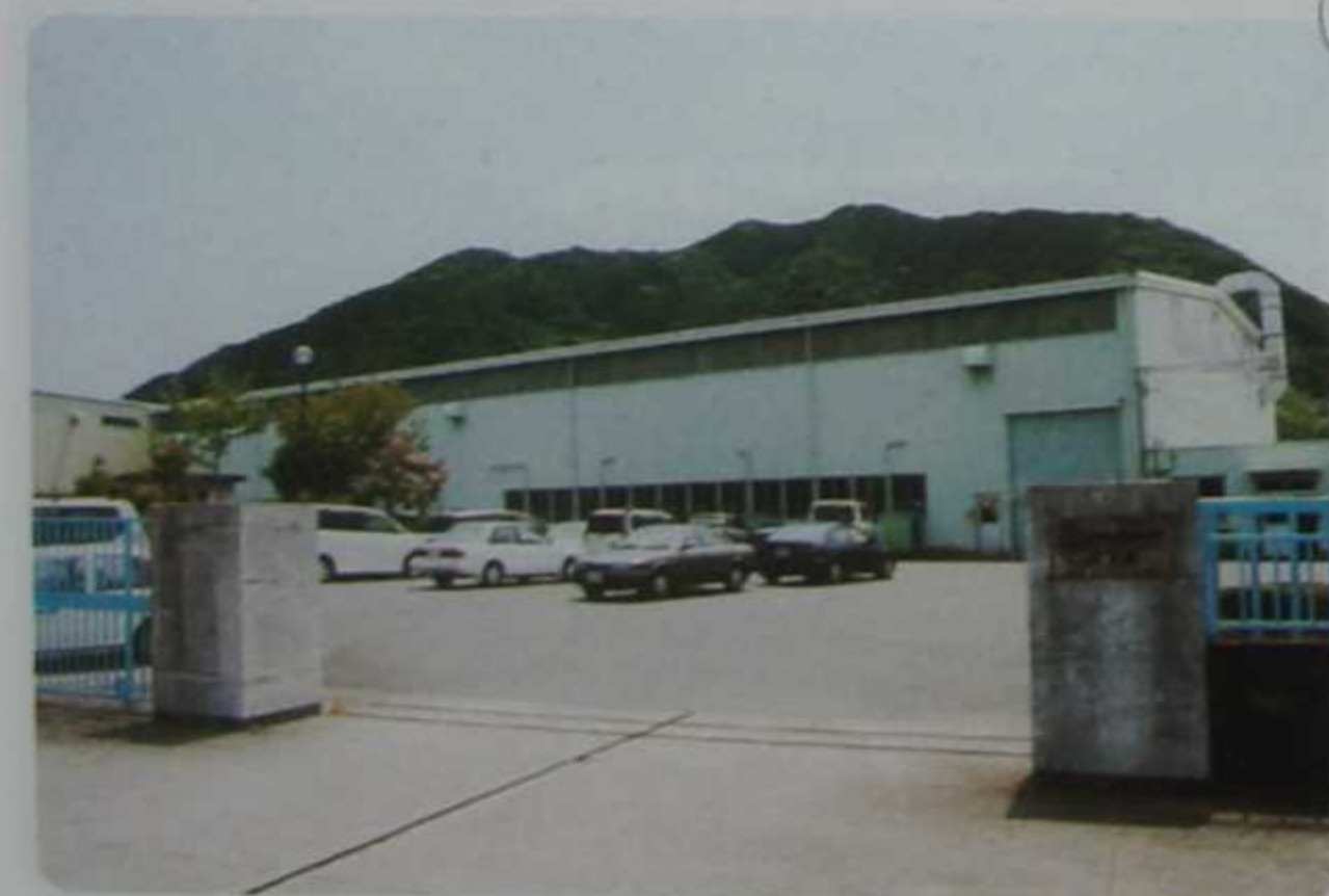
きかいの工場
