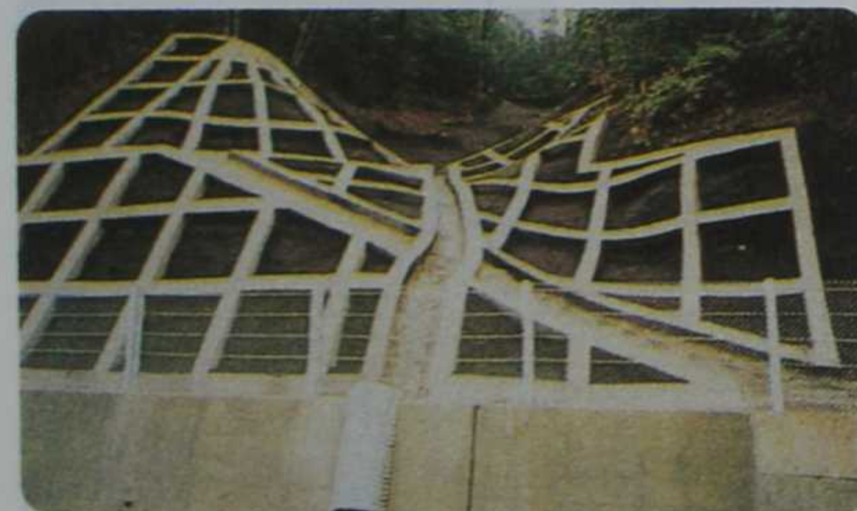
平成9年がけくずれ改しゅう工事
