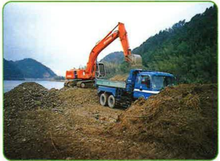
↑川底を深くする工事
