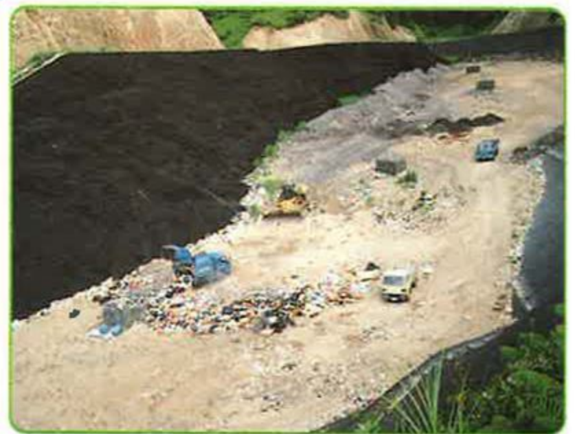
大井不燃物うめたて処分場
