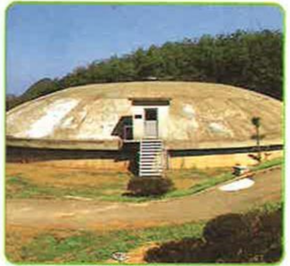
↑上野配水池内タンク
