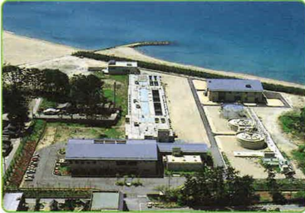
↑萩浄化センター (堀内西ノ浜)
