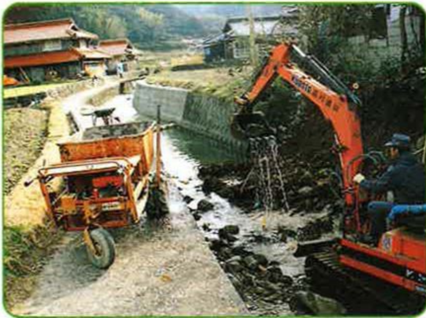
↑川岸をじょうぶにする工事
