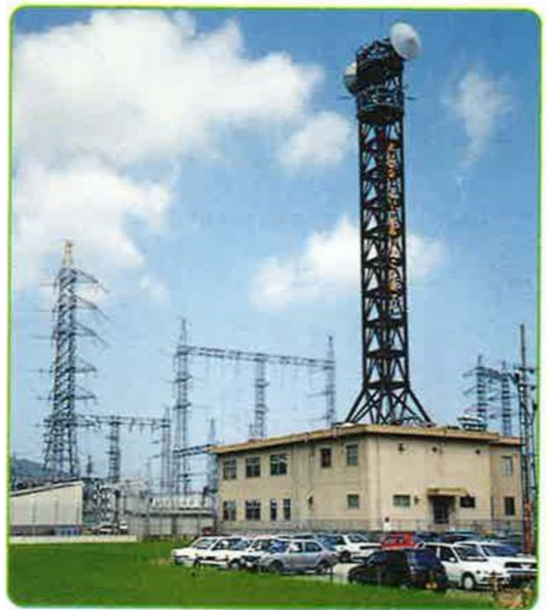
↑ へんでんしょ 萩変電所(椿)
