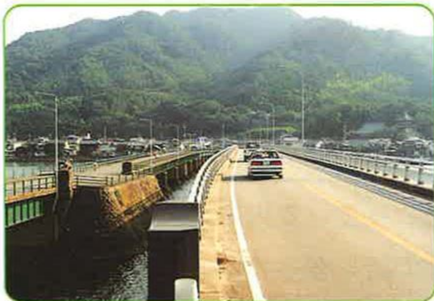
↑ 歩道と車道を分けた橋(常盤橋) ときわ
