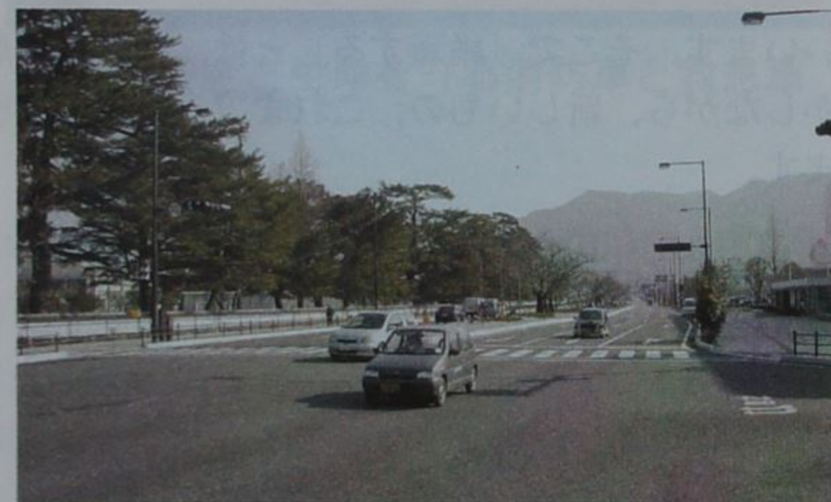
拡幅工事が完了した国道191号
