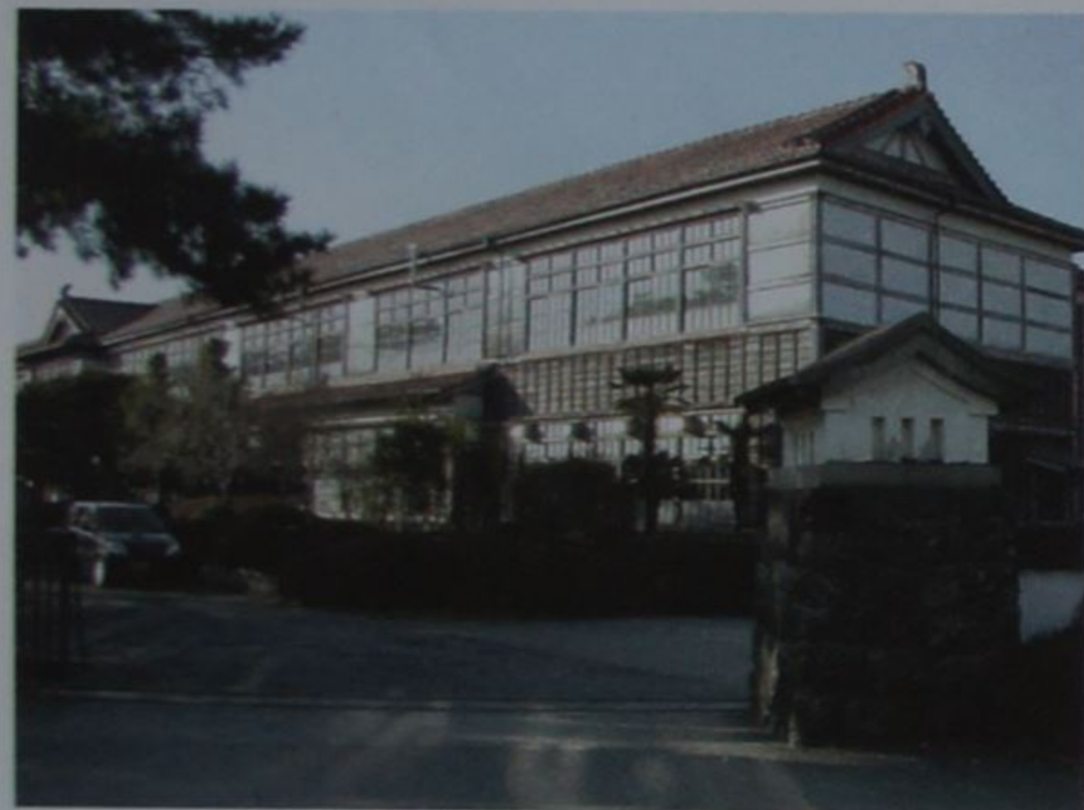
明倫小学校本館
