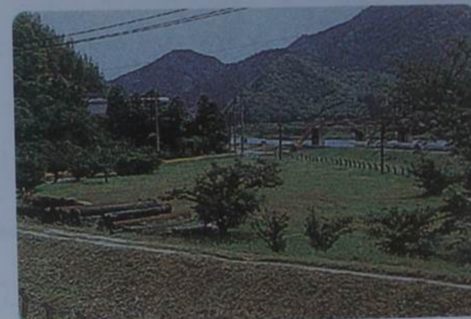
上津江水源地
