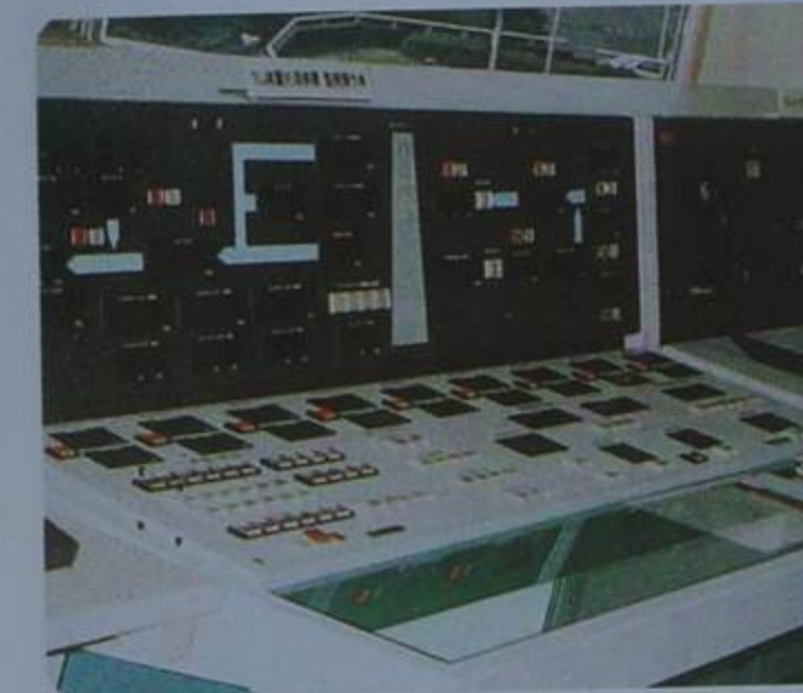
ダムかん理事む所のテレメーター室
