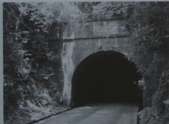
● 萩往還沿道メモ 悴坂御駕籠建場のある場所の真下を鹿背隧道(トンネル)が貫く。明治十六年に着工し翌年完成。明治十年代に作られた石張り道路隧道として大変稀少で、一八二mの総延長は我が国最大の長さとなっている。
