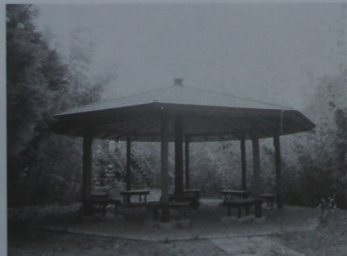
展望台は六角屋根のしゃれたデザイン。その奥に崖に突き出すように展望橋が設置されている。リアルに描かれた遠望イラストの解説板が設置されているが、「竹藪を取り除いた想像図」との断り書きがある。
