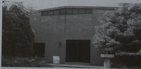
日立金属九州工場铸件記念館（福岡県京都郡苅田町長浜町）
