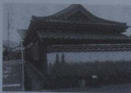
基礎石への建物の乗り方で江戸期長屋（右）と戦後の移築長屋（左）が判別できる
