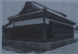
基礎石への建物の乗り方で江戸期長屋（右）と戦後の移築長屋（左）が判別できる
