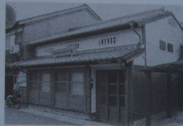
老朽家屋を修理した集会施設
