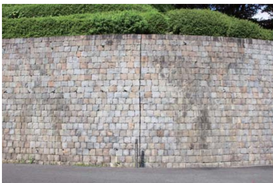
写真㉔ 擁壁-1 (石積み)
