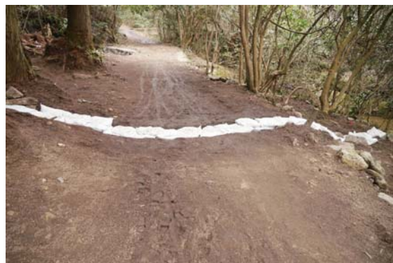
写真16 遺構保護完了
