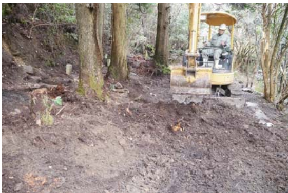
写真11 表土除去機械掘削状況（南から）
