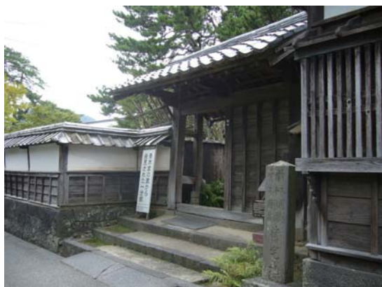
青木周弼旧宅 修理前
