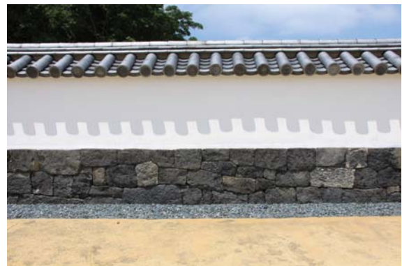
土橋土塀の漆喰の塗り替え
