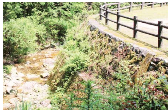
写真⑱ 護岸擁壁
