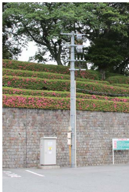
写真㉕ 電柱と照明
