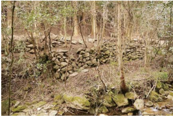
写真9 鉄の道接続部石垣（東から）
