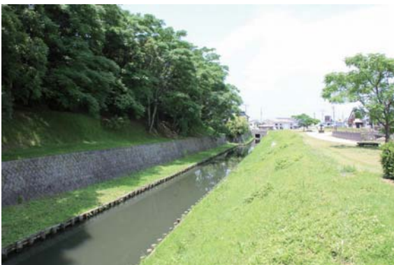
土塁の補修や木柵水路の取り換え
