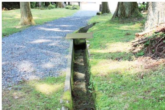
写真⑰ 排水施設
