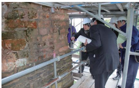
修理委員会現地視察
