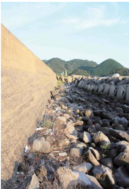
写真⑰ 護岸（北西から撮影）
