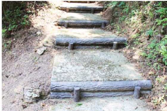
写真⑮ 遊歩道階段
