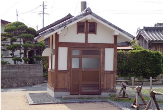
写真③⑦ 消防設備用ポンプ室（外堀地区）
