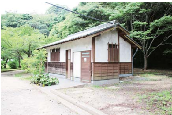
写真㉖ 公衆トイレ
