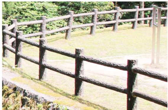
写真⑯ 転落防止柵
