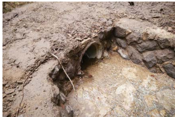
写真14 埋設水路土砂撤去状況
