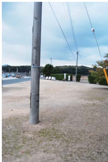
写真⑳ 電柱・電線（北東から撮影）
