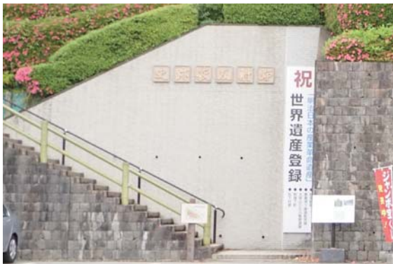
写真⑳ 擁壁-2 (タイル張り)
