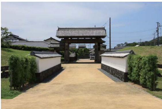
北の総門及び土橋等の建造物の屋根の葺き替え
