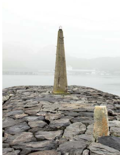
写真⑱ 灯台（北西から撮影）
