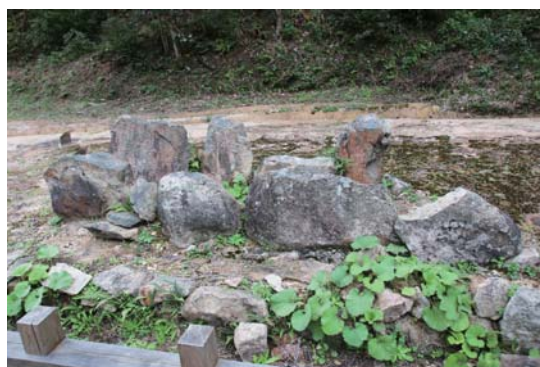
露出遺構の現況
