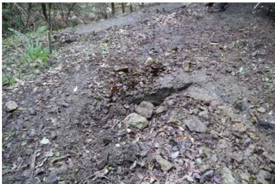
写真13 水路埋没状況
