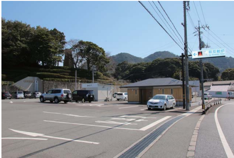
史跡萩反射炉前の屋外トイレ及び駐車場
