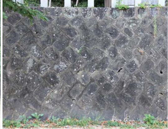
写真⑭ 恵美須社擁壁（南東から撮影）
