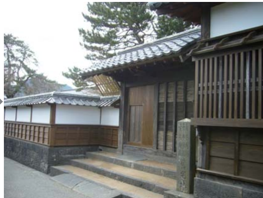
青木周弼旧宅 修理後
