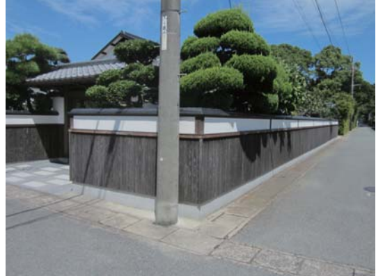
堀内伝建地区 工作物の修景（後）
