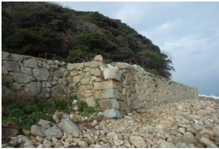
北矢倉跡南方土堀石垣修理 (左) 修理前〔平成 27 年度 (2015)〕
