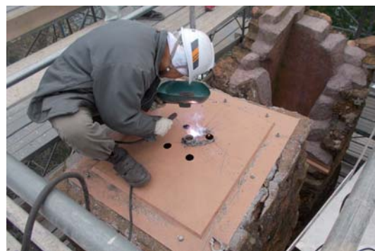
煙突天蓋改良工事
