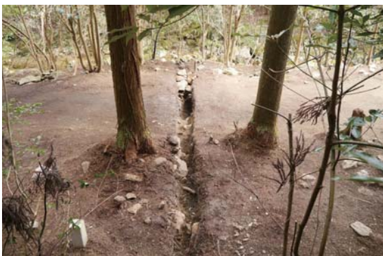
写真7 鉄の道接続部トレンチ2（西から）
