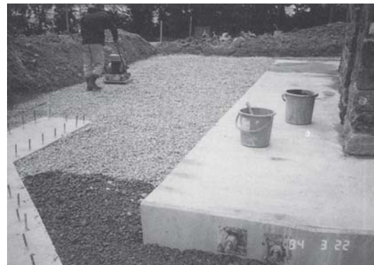
コンクリート耐圧盤下、敷砂利の圧縮状況
