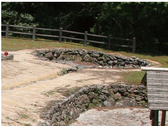
写真① 遺構石組（鉄池跡）
