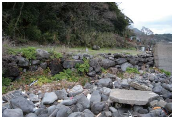
写真② 石積み（南から撮影）
