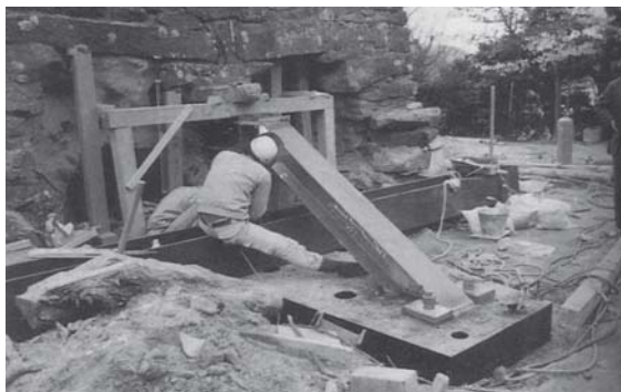
炉体北側中央部変形防止鋼製支柱の施工状況
