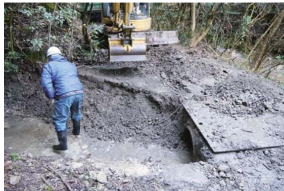
写真12 埋没水路機械掘削状況（南から）
