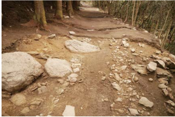
写真2 鉄の道接続部発掘調査終了（南から）
