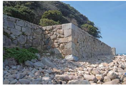
(右) 完了後〔平成 28 年度 (2016)〕
