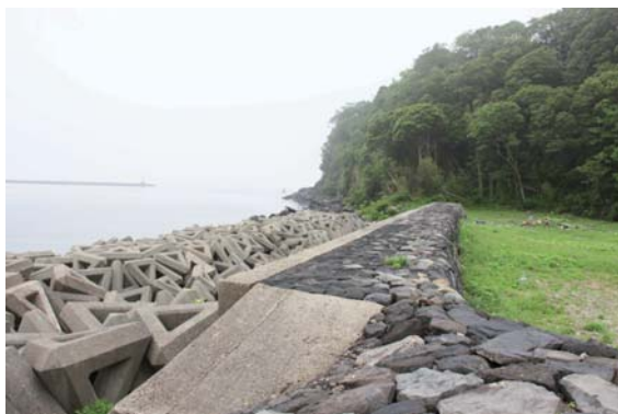
写真① 石積み及び護岸（南東から撮影）
