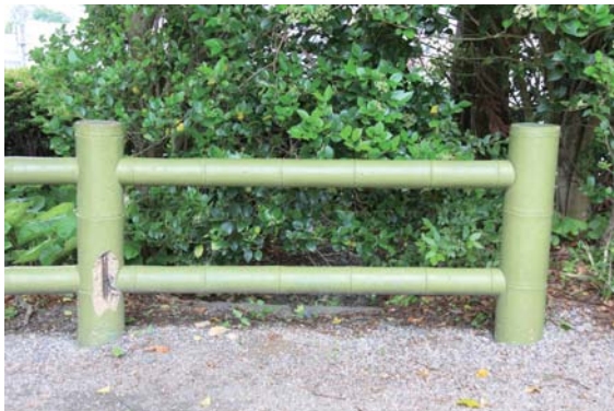
写真⑲ 擬竹転落防止柵
