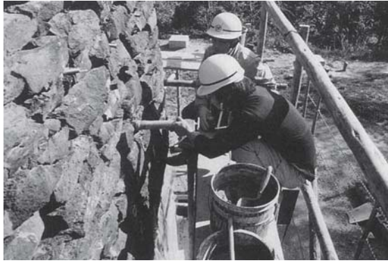
目地充填作業状況
