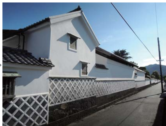
重要文化財菊屋家住宅 修理後
