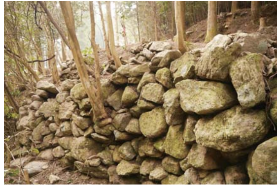
写真10 鉄の道接続部石垣（北東から）
