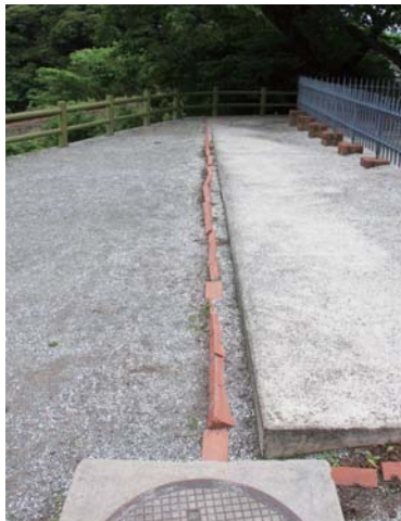
写真⑤ 反射炉本体周辺舗装
