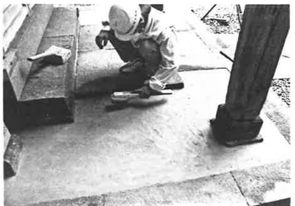
398. 向拝土間叩き施工状況
