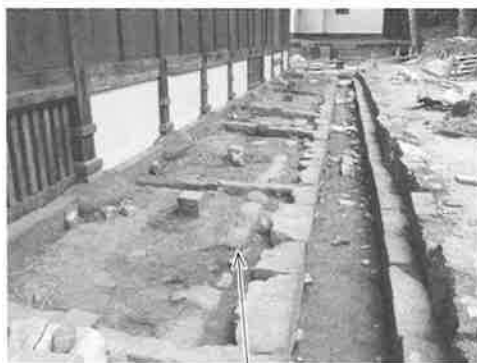
写真4-11 本堂西面 既存雨落石内側の石列地盤造成時に設けられた「仮の雨落石」と考えられる
