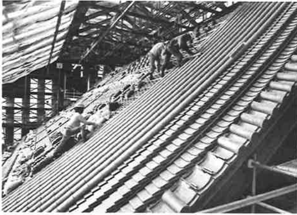
155. 丸瓦施工状況
