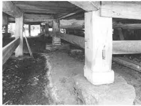
写真4-14 正八幡宮拝殿柱
