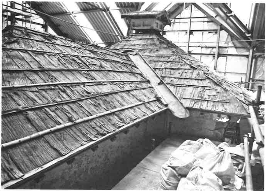
334. 置屋根 葺土解体完了 南西より見る 土居葺は全面杉皮葺で、昭和52年頃の施工とみられる
