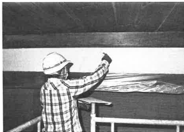
167. 内部蟻壁漆喰塗施工状況
