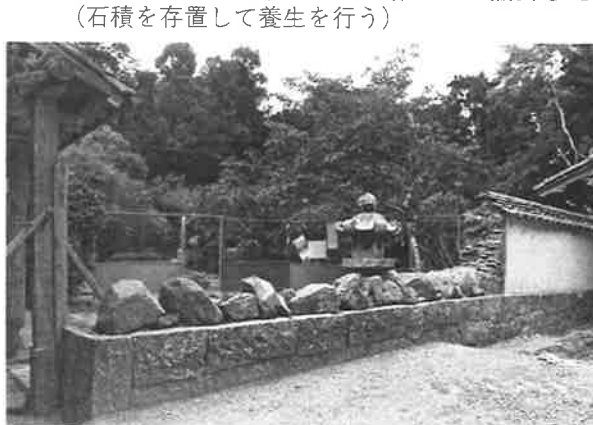
222. 土塀 内部瓦積、壁土解体状況 石積上に石が並べられている。割石のほか、転 用石片などを含む
