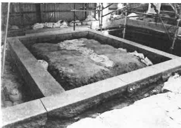
391. 礎石の据え直し完了
