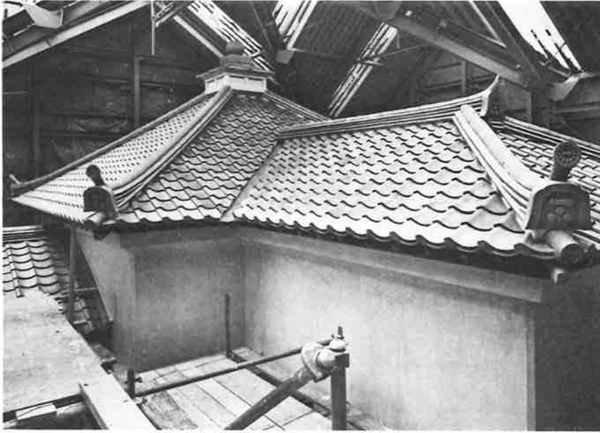
377. 瓦葺、壁施工完了 北東より見る
