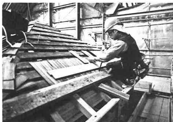
407. 本体屋根 土居葺状況 修理前に倣い、手割の木端板を使用した
