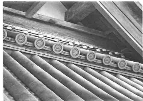
166. 瓦目地漆喰塗状況
