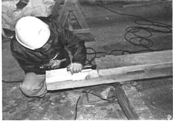
400. 柱の根継状況
