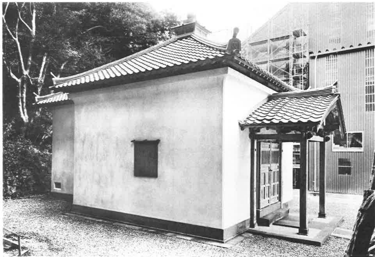
317. 竣工 正側面（南東より見る）
