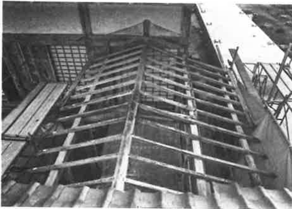
213. 書院渡り廊下 垂木の状況 北より見る
