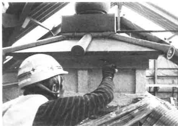
421. 露盤 鼠漆喰塗施工状況
