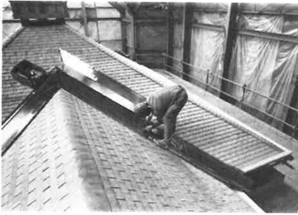
409. 谷銅板取付状況
