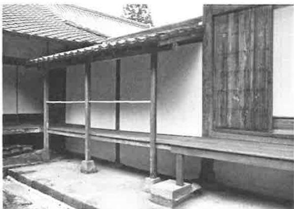
219. 書院渡り廊下 復旧完了
