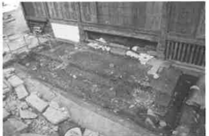
【写真10】同右 雨落石撤去 (北西から)
