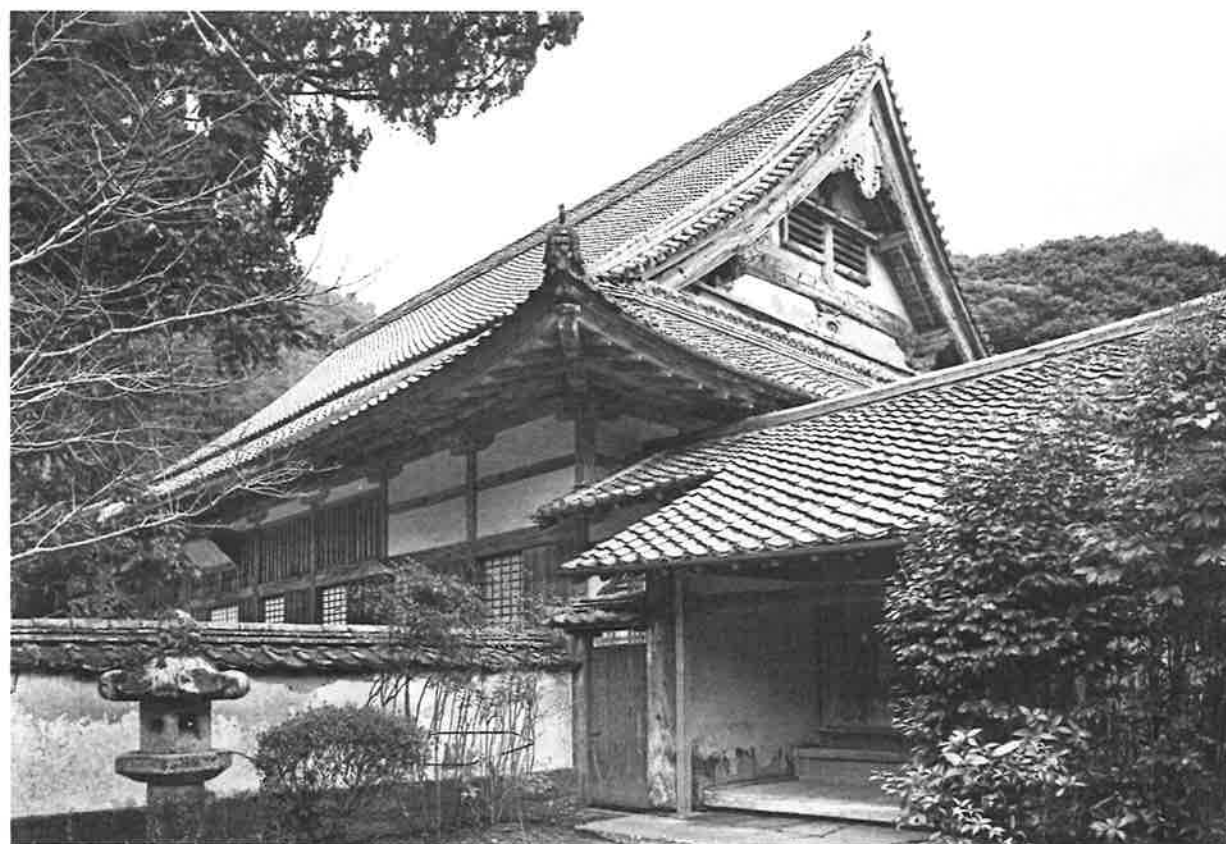
27. 修理前 正側面（北東より見る）
