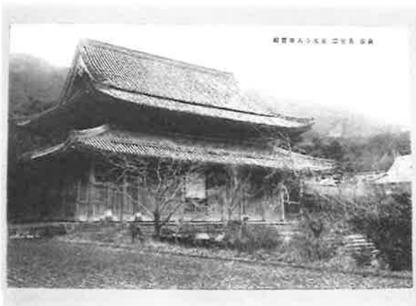
113. 要旨九 類例 写真絵葉書 東光寺大雄宝殿（東光寺所蔵） 鉾葺で降棟がなく、大照院本堂とよく似ている
