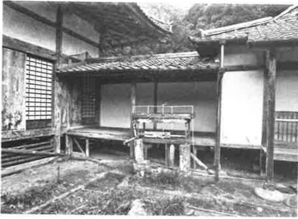
211. 書院廊り廊下 解体前 東より見る
