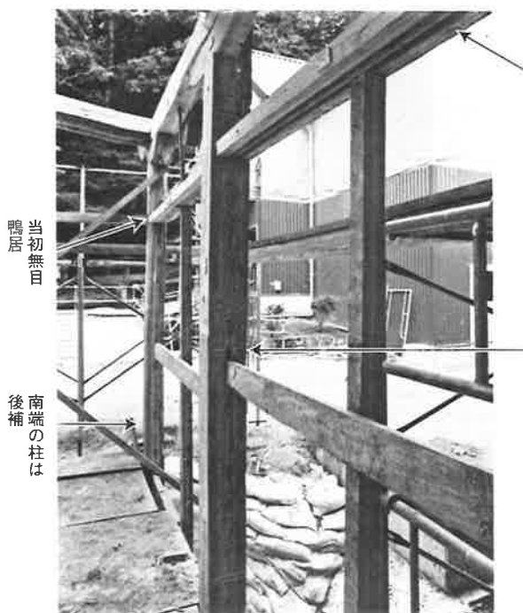
101. 要旨六一三 南面廊下西面の痕跡 南側の間口には当初材の無目鴨居が残存し、中敷居の痕跡がある。残存する二間とも窓（開放）とみられる
