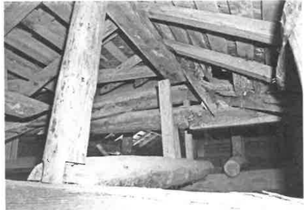
464. 西面張出しから主体部との取合いを見る 主体部の本体屋根を削り抜き、梁や隅木を付加 して小屋組を一体化させている
