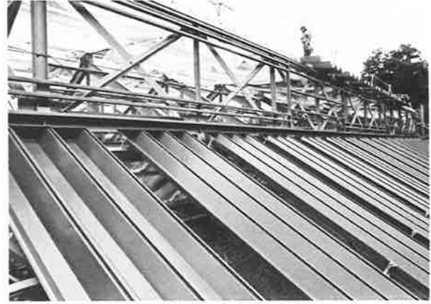
204. 本堂 素屋根 建方状況（屋根）
