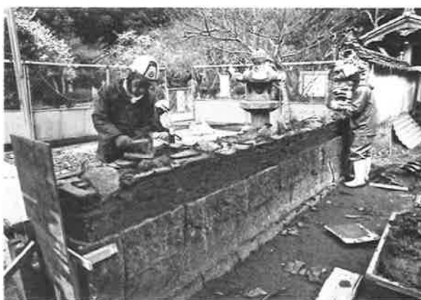
224. 土塀 復旧状況
