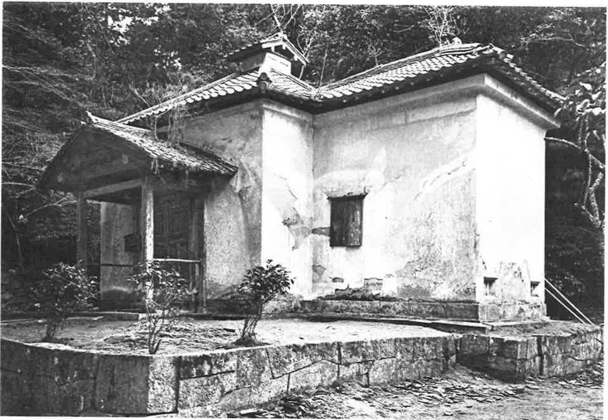
326. 修理前 正側面（北東より見る）
