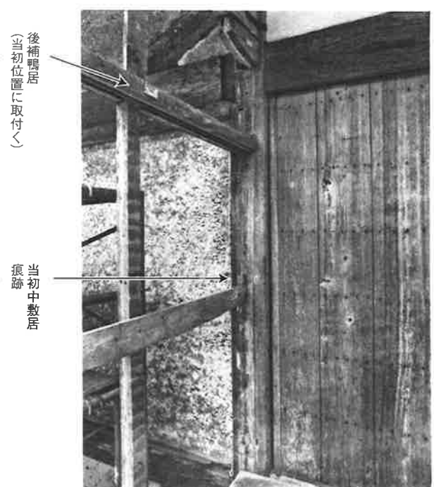
101. 要旨六一三 南面廊下西面の痕跡 南側の間口には当初材の無目鴨居が残存し、中敷居の痕跡がある。残存する二間とも窓（開放）とみられる
