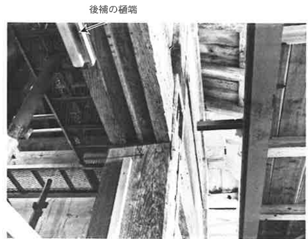
99. 要旨六一七 側廻り西面 二本溝の鴨居 諸溝で、広縁に納まる横舞良戸の鴨居溝と同じ納まりである。当初、御書院渡り廊下が取付いていた
