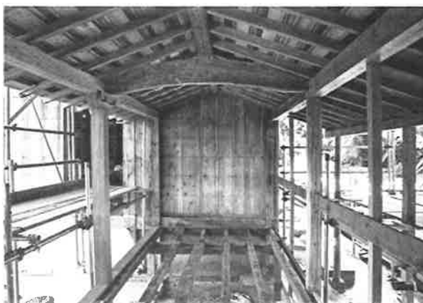
218. 書院渡り廊下 軸部組立状況
