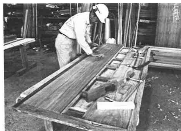
169. 板戸補修状況
