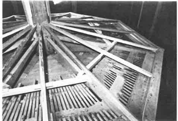
434. 輪蔵 上部の施工状況
