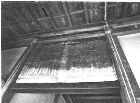
89. 要旨二 敷居解体後 足固（敷居溝）痕跡 （北より七間目） 足固上の敷居溝には建具の使用痕跡がある （板戸は戸車付で、樋端上を走る）
