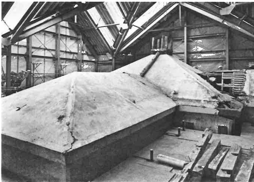
339. 本体屋根状況 北西より見る
