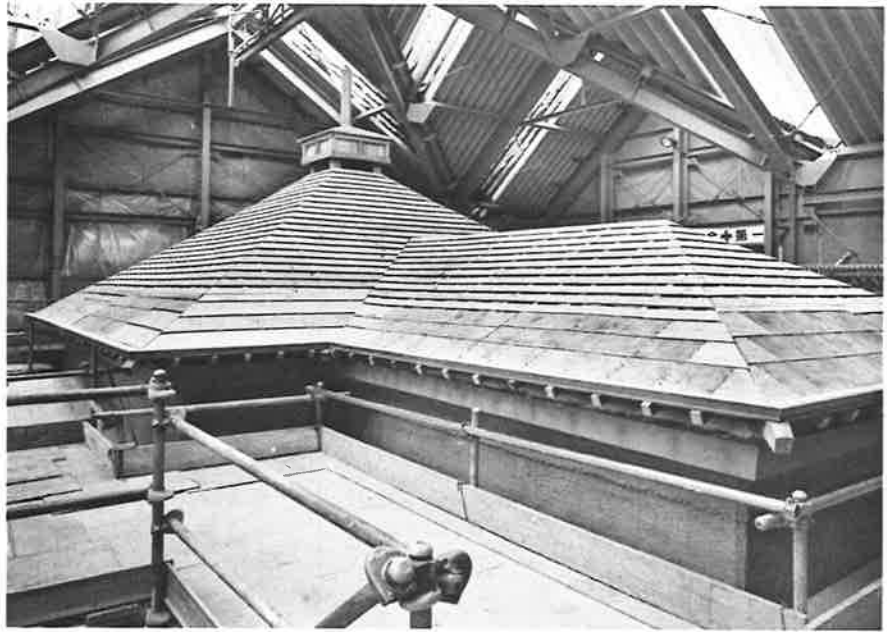
374. 置屋根 野地板組立完了 北東より見る
