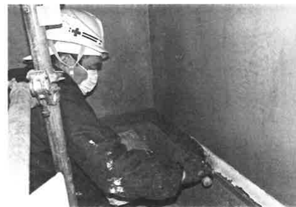
422. 帯漆喰(鼠漆喰)施工状況
