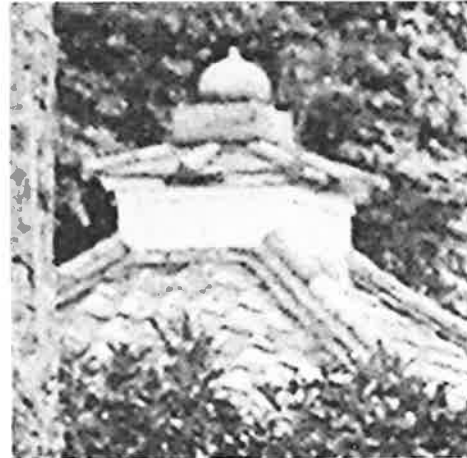
354. 経蔵 要旨一 (一) 古写真部分 (山口県文書館所蔵) 宝形屋根 屋根は棧瓦葺である
