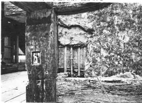
257. 同右 半柱痕跡詳細 桁の痕跡が現状の他、二期認められる。当初桁は半柱天端に置かれる
