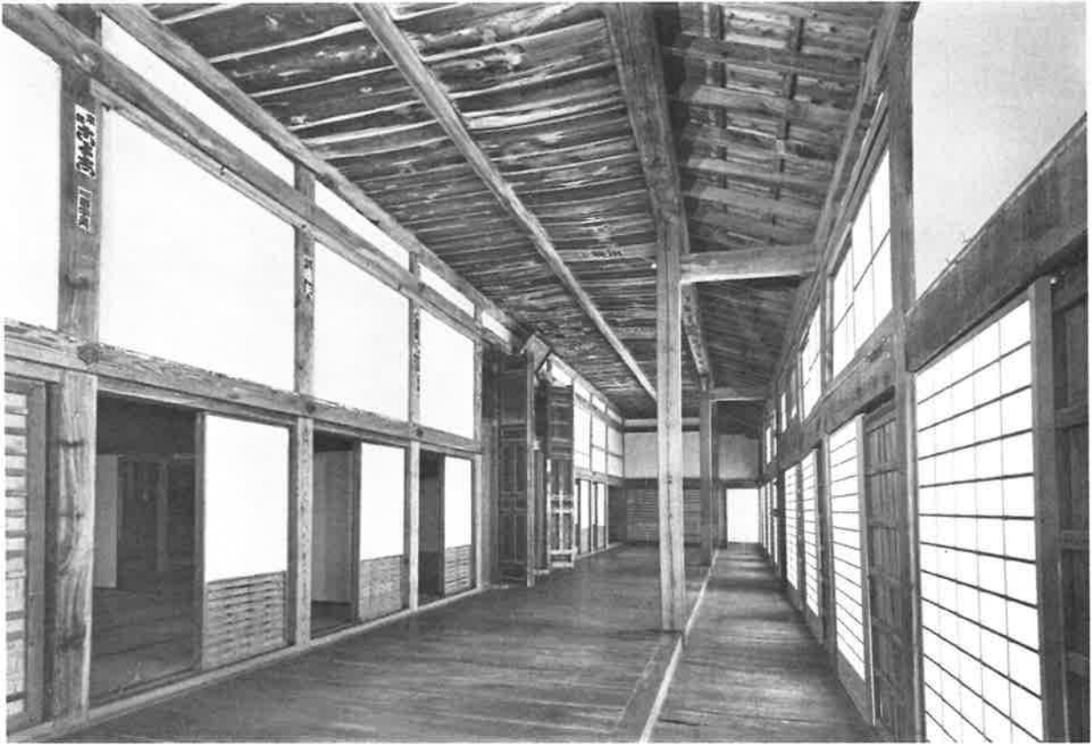
34. 修理前 東広縁（南より見る）
