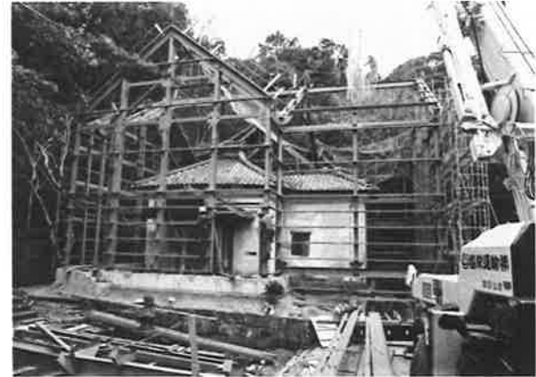
206. 経蔵 素屋根 建方状況
