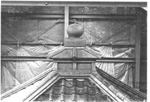
412. 露盤宝珠 施工完了
