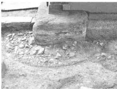
写真4-10 柱礎石と地業の様子
