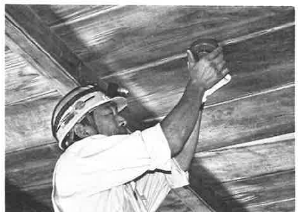
184. 自動火災報知設備施工状況
