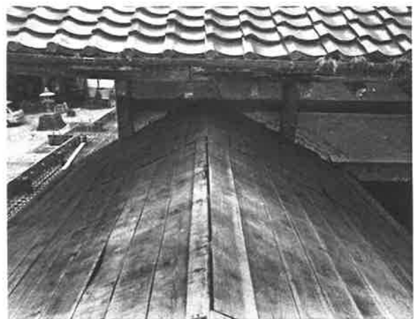
300. 北面式台玄関及び廊下 野地板の状況 詳細 壁際一間は当初野地板が残存している
