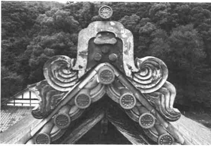
285. 類例 庫裏の鬼瓦 大棟鬼瓦は、庫裏のものを参考に新調した
