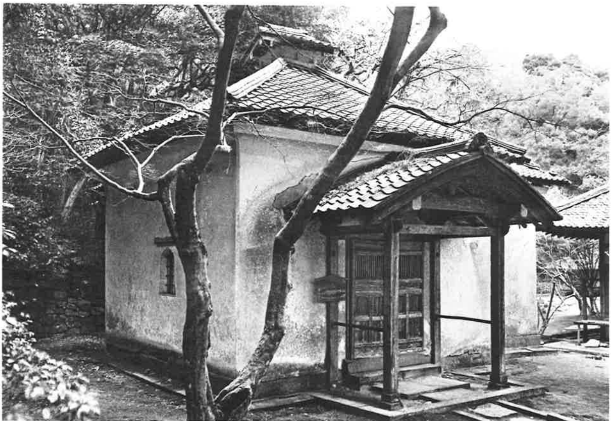
327. 修理前 正側面（南東よりみる）
