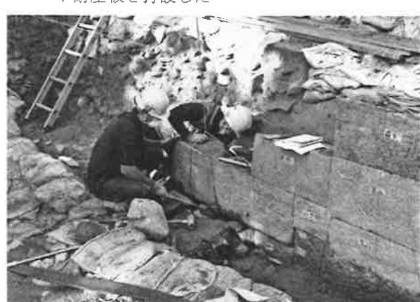
388. 東面石垣の積み直し状況 北面石垣とは異なり、在来の工法で積み直した
