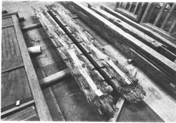
425. 輪蔵 心柱加工状況 1 輪蔵の心柱を二材に分断した
