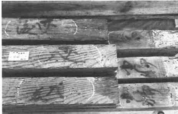
509. 力垂木 (地垂木) の番付 (上から「廿八後」 「廿八」「廿八前」、鼻先はいずれも「北輪」) 力垂木は二間毎に三本ずつ入れられる
