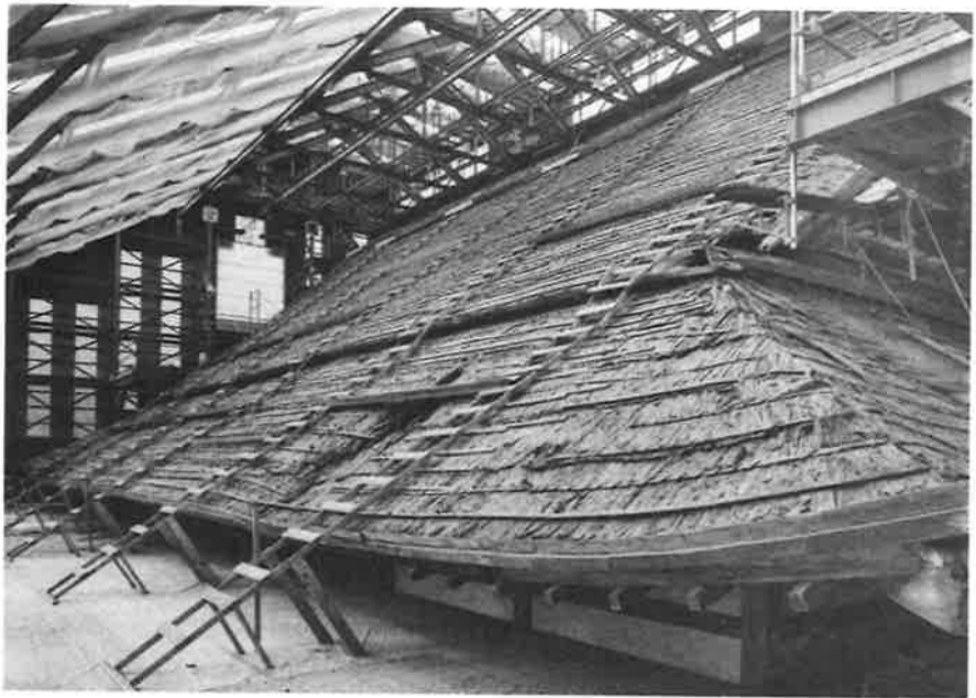
54. 瓦・葺土解体完了 東面 北東より見る
