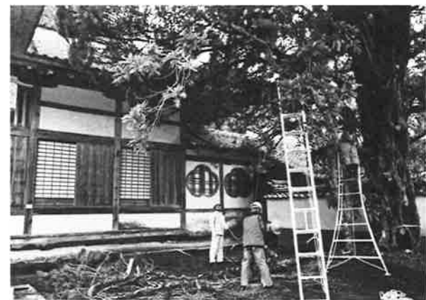
208. 共通工事 樹木伐採状況
