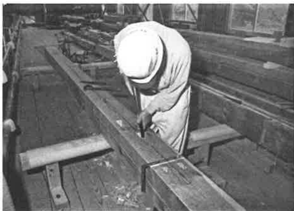
143. 新調柱加工状況
