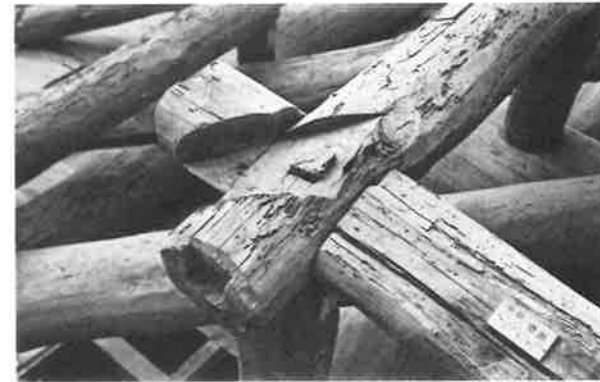
264. 母屋 隅の仕口 束の重柄を延ばして、野隅木の滑り止めを兼ね たとみられる。野隅木は全て後補材であった
