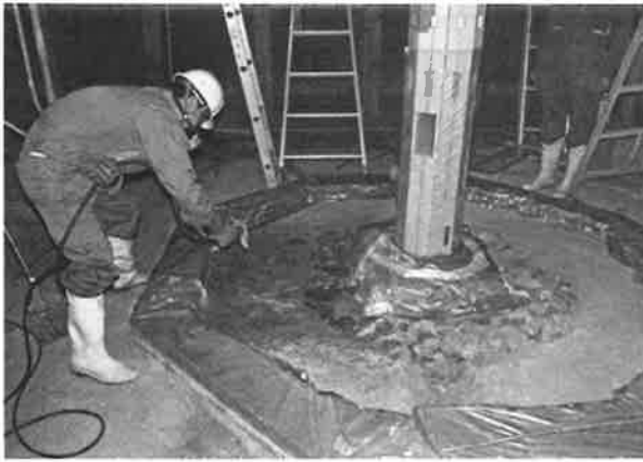
441. 土壌処理状況
