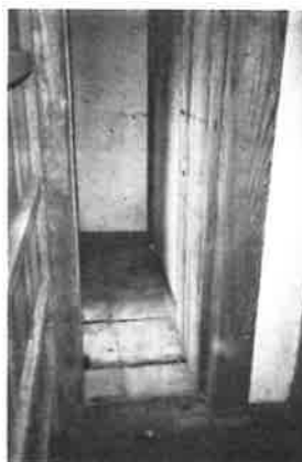
495. 同右の詳細写真 トコの柱が写る
