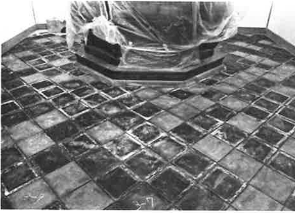
393. 四半敷瓦据付状況 周囲に漆喰の残る瓦は再利用材
