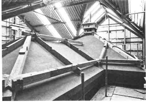
416. 本体屋根 中塗状況 (主体部・西面張出し)
