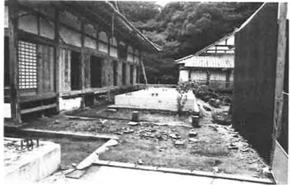
308. 北面式台玄関及び廊下 解体完了 東より見る
