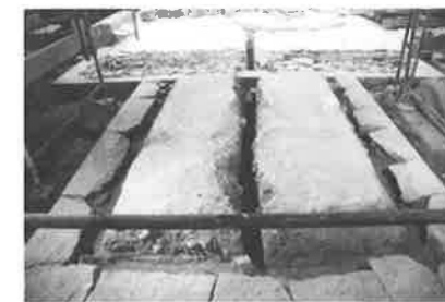
【写真24】北張り出し部 下段礎石 (北から)
