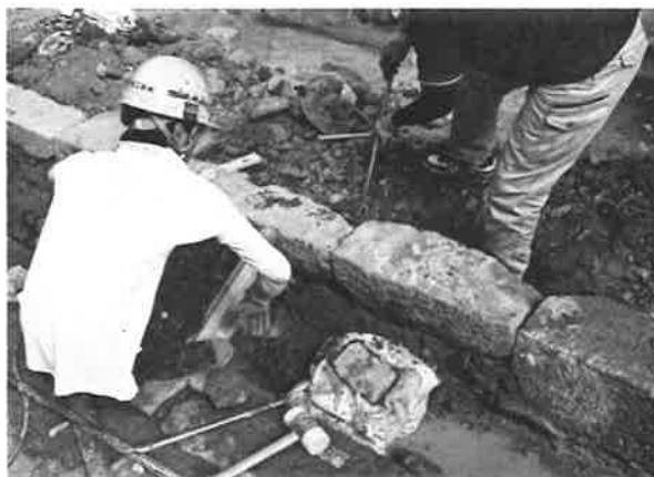
140. 雨落石据え直し状況
