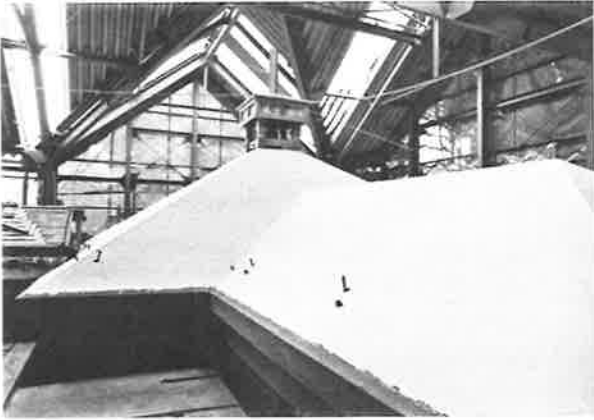
417. 本体屋根 漆喰塗状況(主体部・西面張出し)
