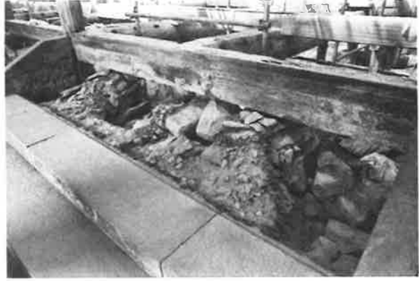
260. 正面石段解体状況 礫を敷いた上に土で整地し、割石の端材や瓦を 飼い込んで石を据えている 棟通り
