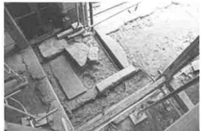
【写真11】東区北端 石組7 (北西から)
