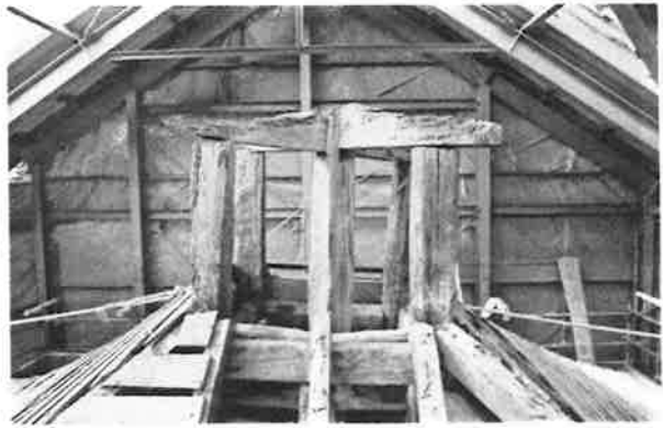
350. 経蔵 要旨一 (一) 宝形屋根 (現状切妻屋根) 解体状況 柱頂部で交差する部材から、宝形屋根の勾配が わかる
