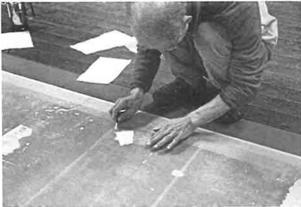
173. 絵襖補修状況 欠失部を新規の間似合紙で補修する
