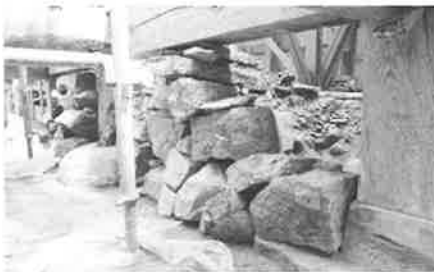
【写真2】背面石積解体状況（南西から）
