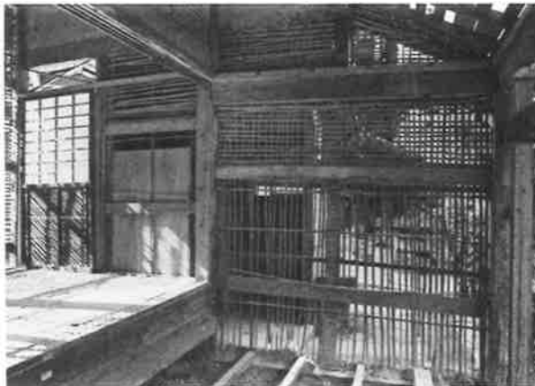
302. 北面式台玄関 雑作材及び土壁 解体状況 玄関の部材には角釘と丸釘が併用されている
