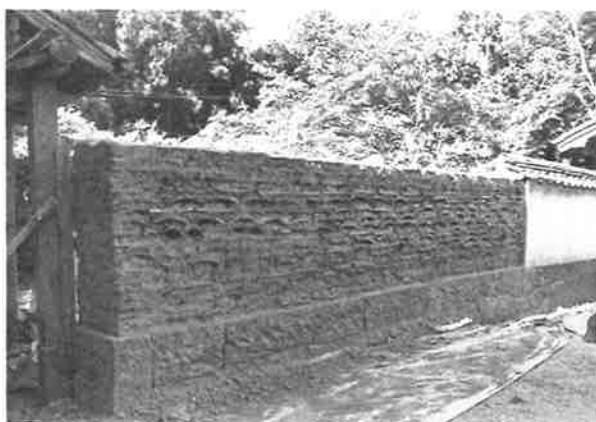
221. 土塀 屋根瓦、漆喰塗及び中途解体状況
