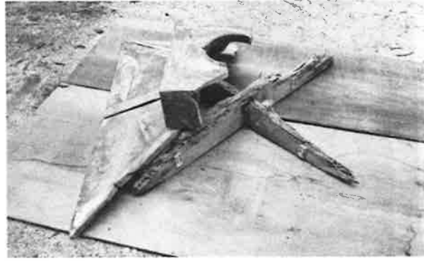
352. 経蔵 要旨一 (一) 宝形屋根の仮組
