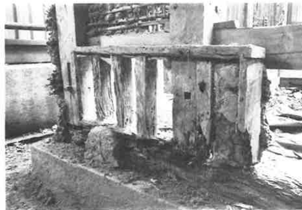
469. 同右解体後の状況 格子を埋めた土は内側から詰められている
