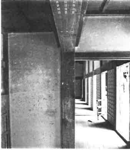
87. 要旨二 入側筋の鴨居痕跡 鴨居には付樋端三本の痕跡があり、 早い段階で建具を設けたとみられ る
