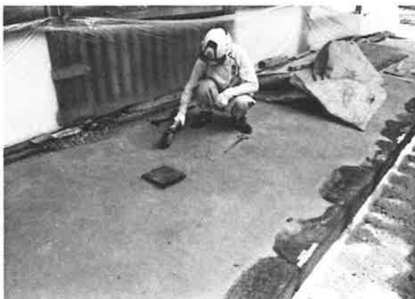
141. 軒下土間叩き状況
