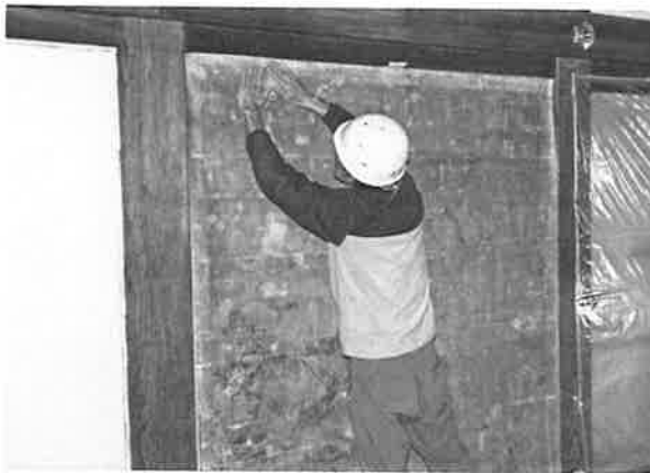
183. 壁貼付復旧状況
