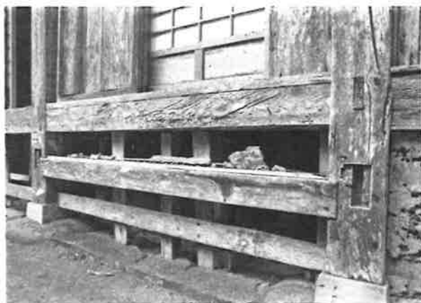
253. 同右痕跡 詳細 根太掛は当初材が残存する。床高は庫裏渡り廊下と同様、本堂より低く、庫裏と同高とする
