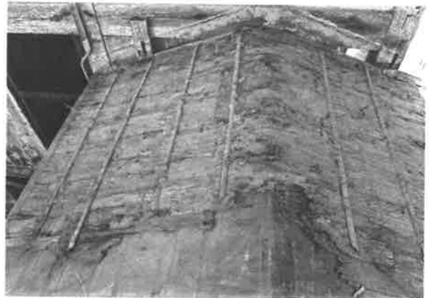
212. 書院渡り廊下 土居葺の状況 北より見る アスファルトルーフィングの上にスギ皮葺としていた
