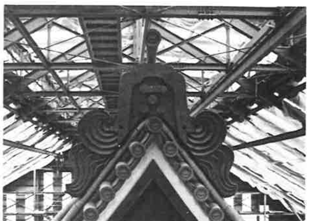
158. 鬼瓦据付完了
