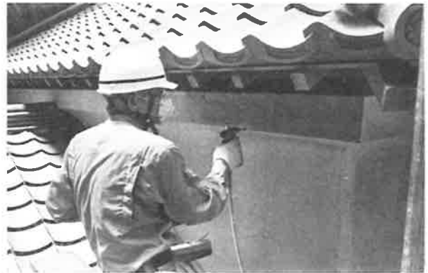
442. 外壁撥水処理状況
