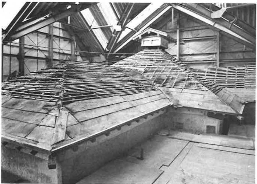
335. 置屋根 土居葺解体完了 北西より見る
