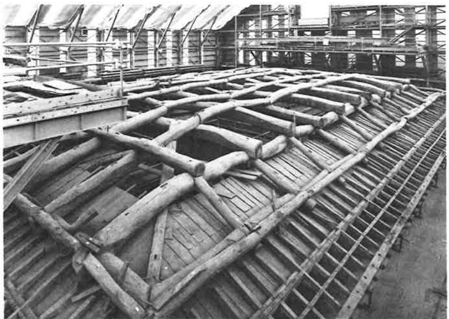
68. 飛檐垂木化粧裏板 解体完了 西面 北西より見る
