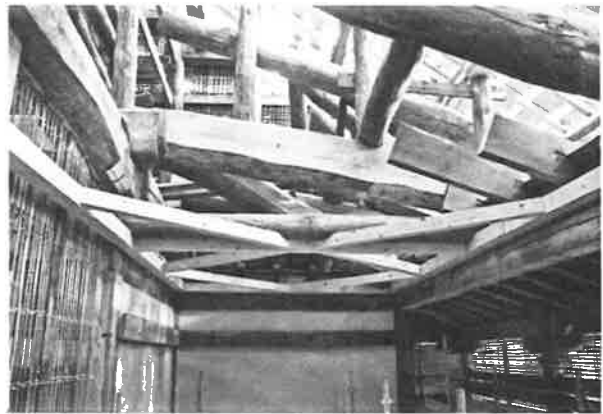
188. 構造補強施工状況 (天井上) 広縁部分に水平構面を設けた
