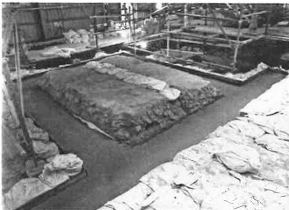
389. 礎石下の基礎コンクリート打設状況 沈下した基礎部分の据え直しを行った
