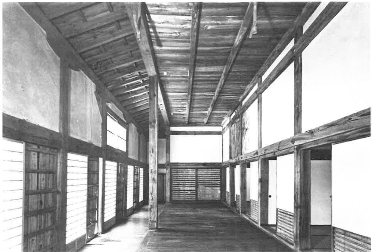
35. 修理前 南広縁（東より見る）
