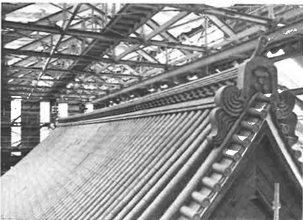
159. 大棟完了 南より見る
