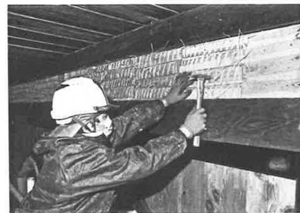
168. 蟻壁下地(仏間上)施工状況
