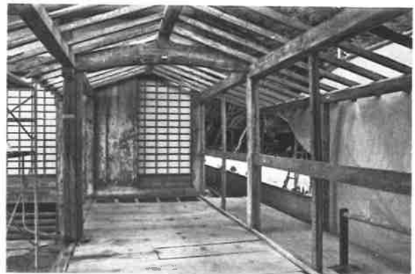
214. 書院渡り廊下 解体状況 北より見る
