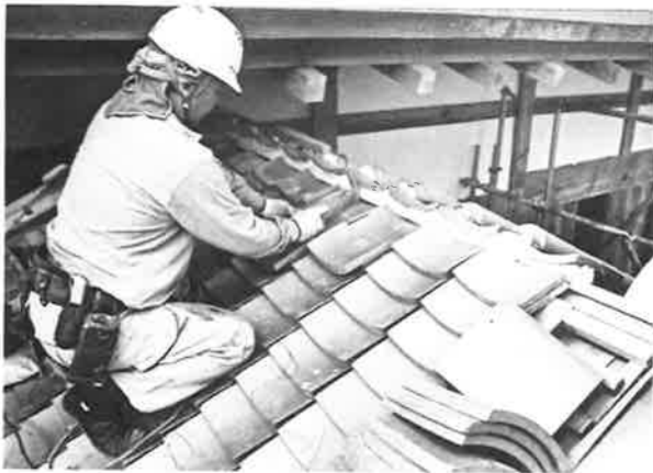
197. 北面式台玄関及び廊下 屋根瓦葺状況
