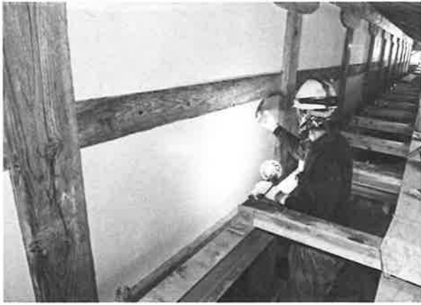
163. 外壁漆喰塗施工状況
