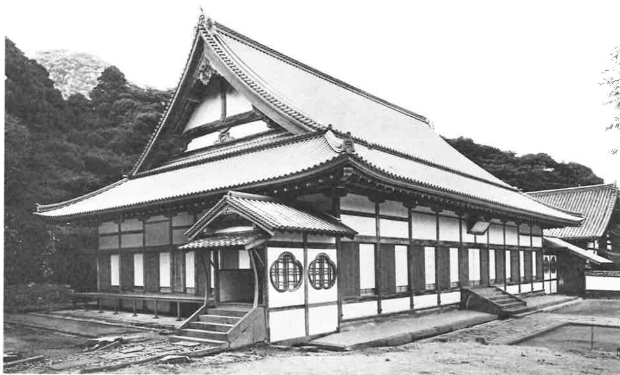
3. 竣工 正側面 (南東より見る)
