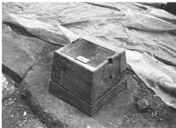
142. 礎盤補修状況
