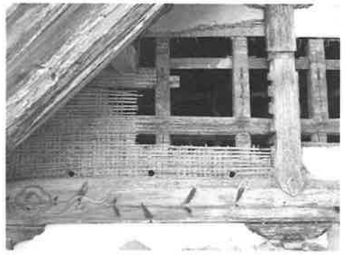
写真4-37 本堂妻虹梁上に空いた壁穴 (写真は北妻)
