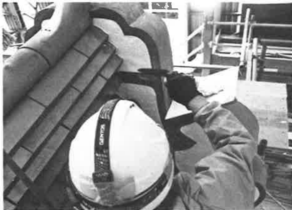
165. 鬼瓦裏面漆喰塗施工状況
