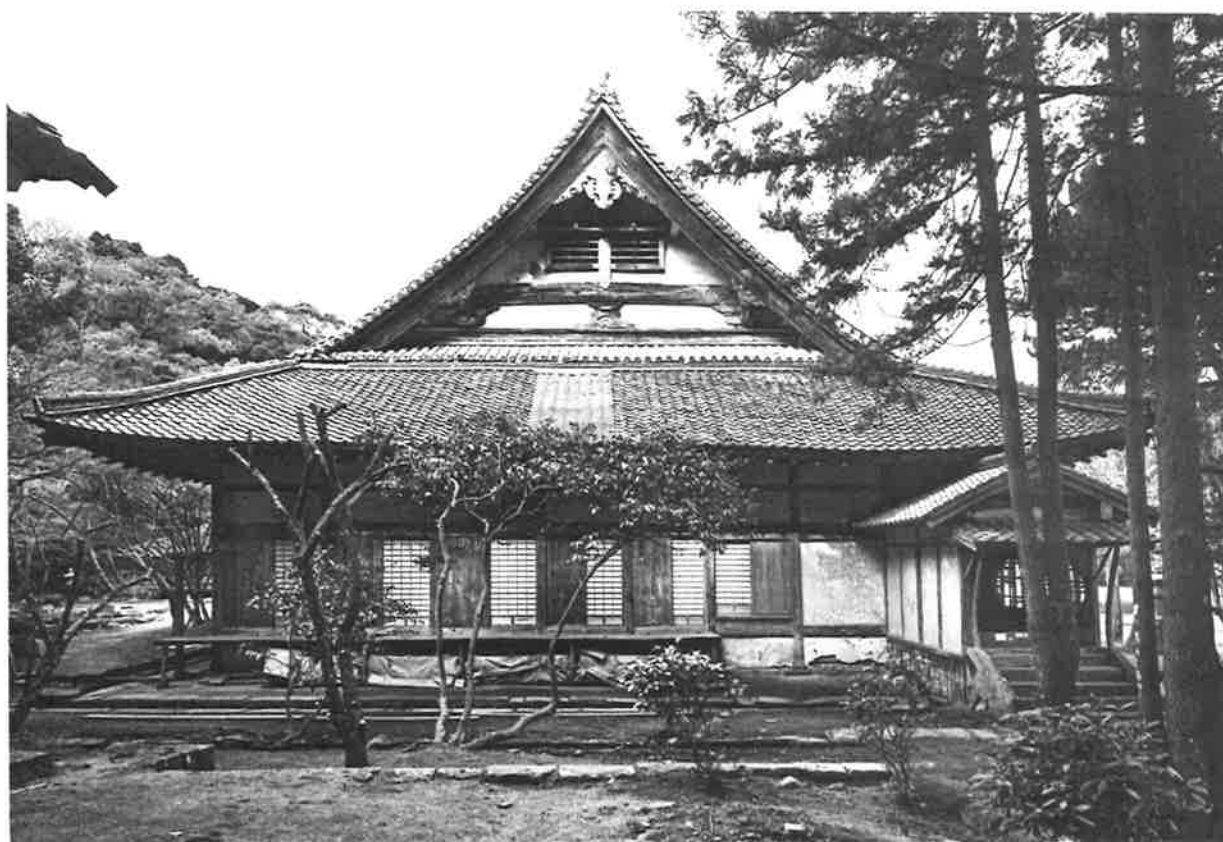
29. 修理前 南側面
