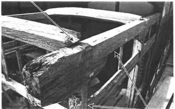
314. 南面廊下 東面 桁端部詳細 柱上に桁の継手が残る
