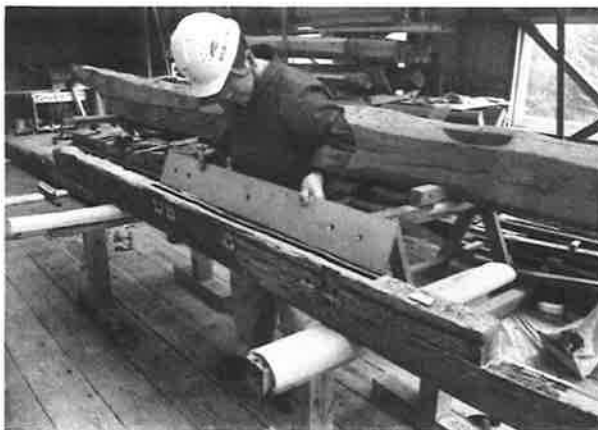
145. 地垂木補強状況 要所の力垂木に鉄板を挿入した
