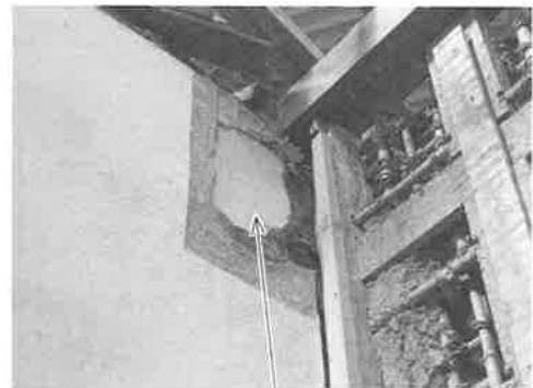
写真4-41 主体部の元外壁に残る鼠漆喰仕上
