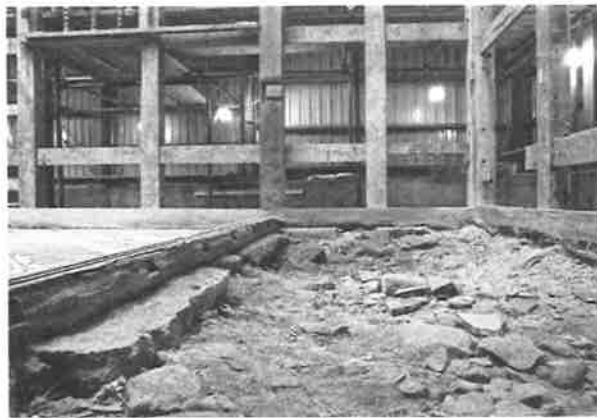
467. 西面張出し 棚下の床痕跡 根太の仕口及び使用釘が残り、床が張られてい た時期がある
