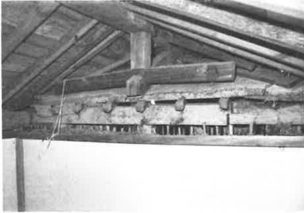
465. 北面張出しから主体部との取合いを見る 西面張出しに対し、北面張出しは主体部の本体 屋根上へのせかけて小屋組をつくる
