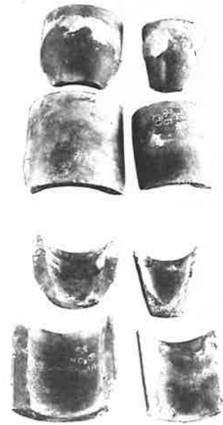
284. 輪違瓦 「阿」の刻印があり、隅棟に 馴染むものを抜粋採用した
