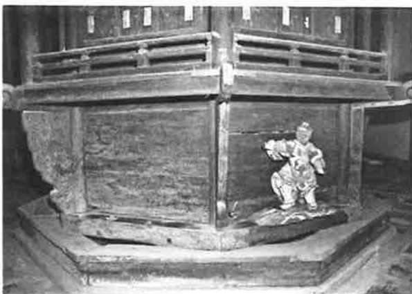
364. 経蔵 要旨三 八天像の取付状況
