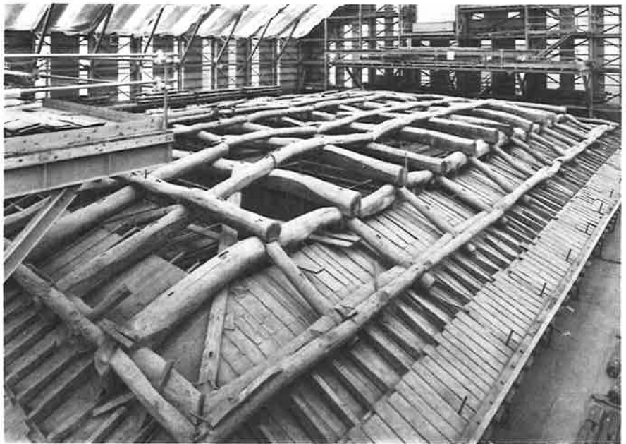
67. 桔木解体完了 西面 北西より見る
