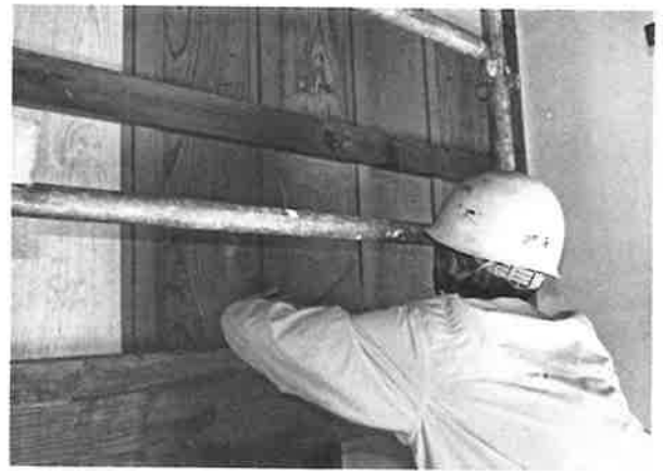
178. 風除紙貼施工状況
