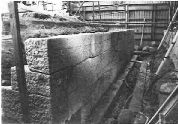
387. 北面石垣の積直し完了
