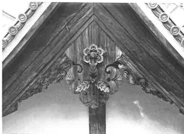
150. 懸魚取付完了
