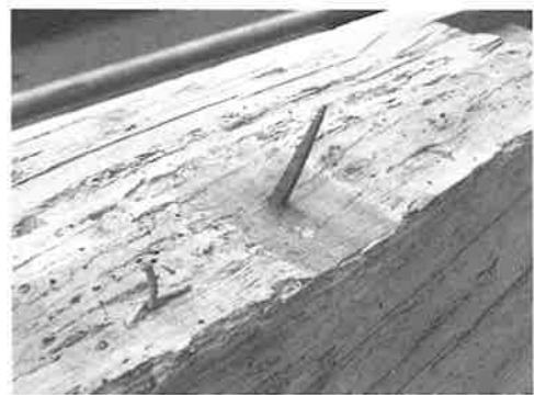
写真4-16 桁上の垂木の止釘 相釘を用いる
