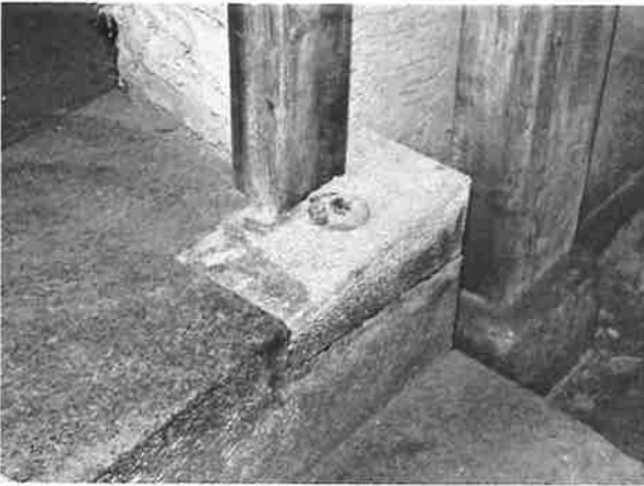
395. 框石補修状況
