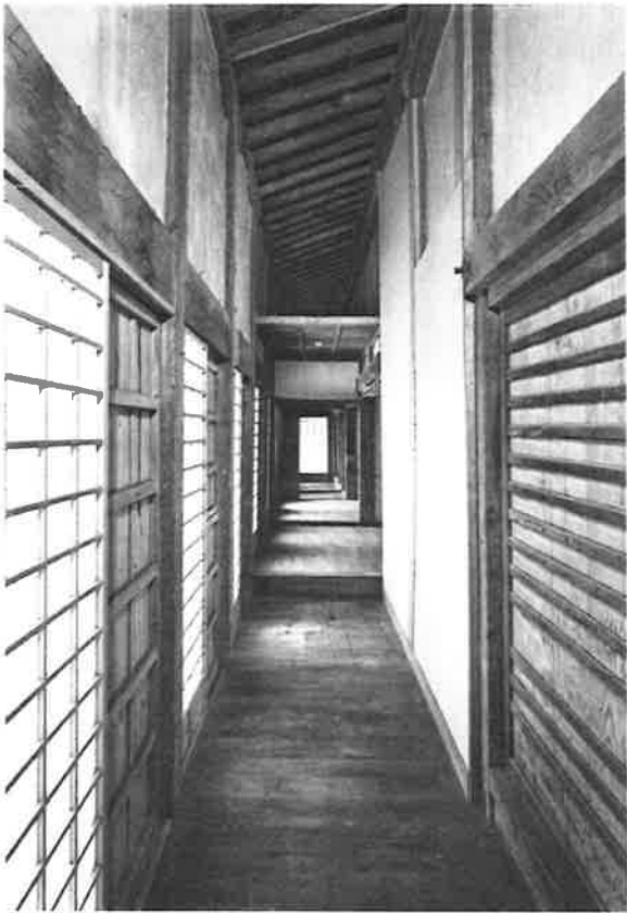
47. 修理前 南西落縁（南より見る）
