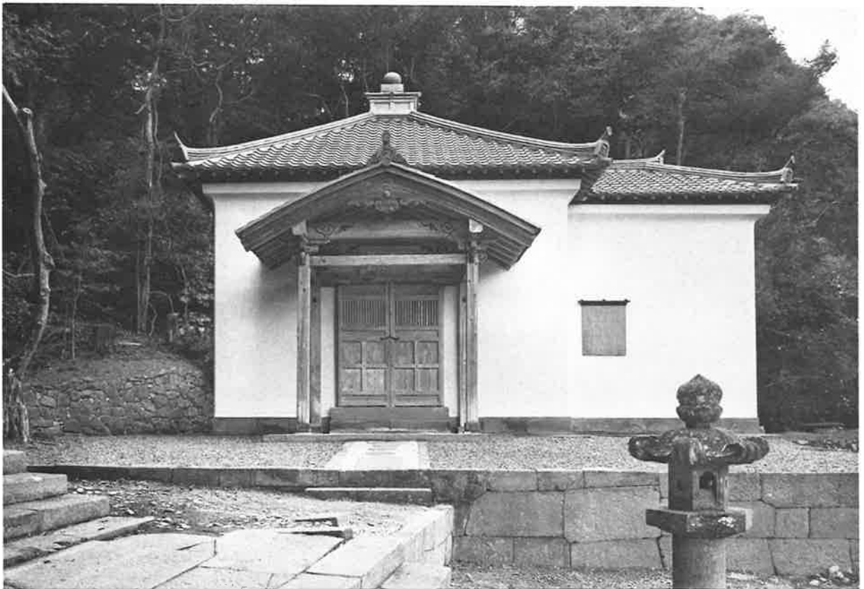
319. 竣工 正面（東より見る）
