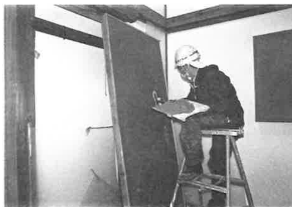
423. 土戸 鼠漆喰塗施工状況
