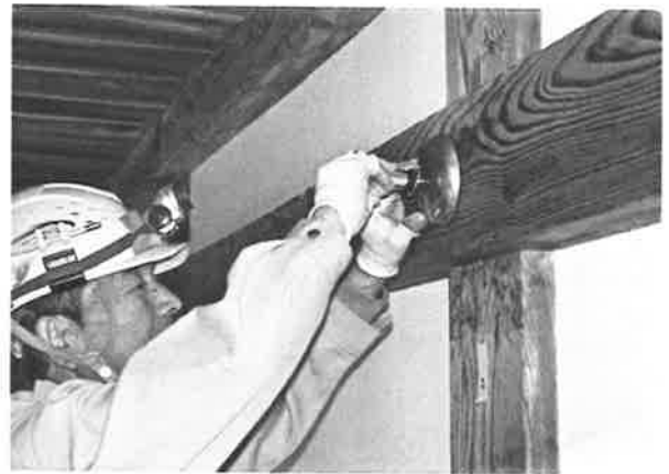
180. 銑金具取付状況
