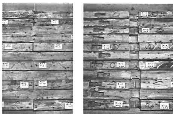
524. 経蔵 格天井格縁継手の合番付
