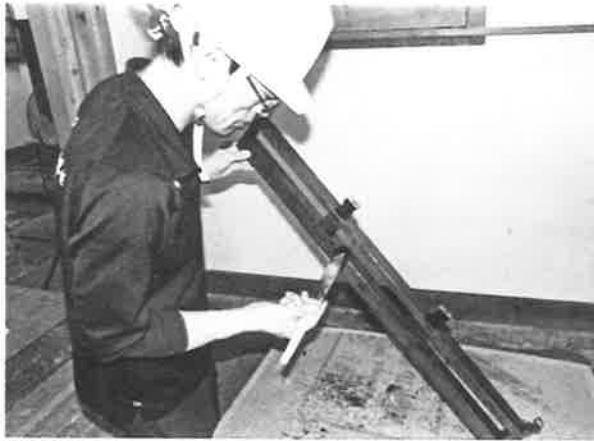
435. 輪蔵 拭漆施工状況
