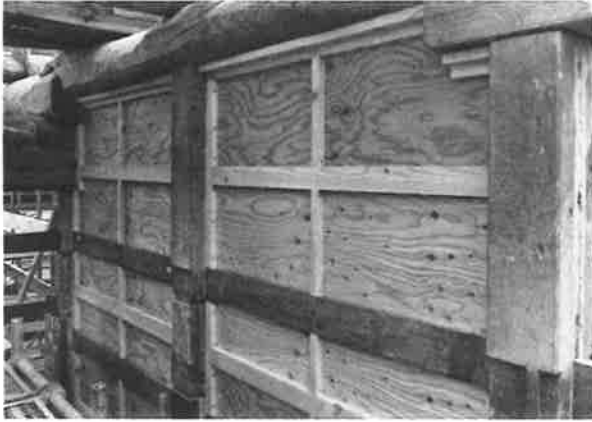
187. 構造補強施工状況 (補強壁) 構造用合板による耐力壁を設けた
