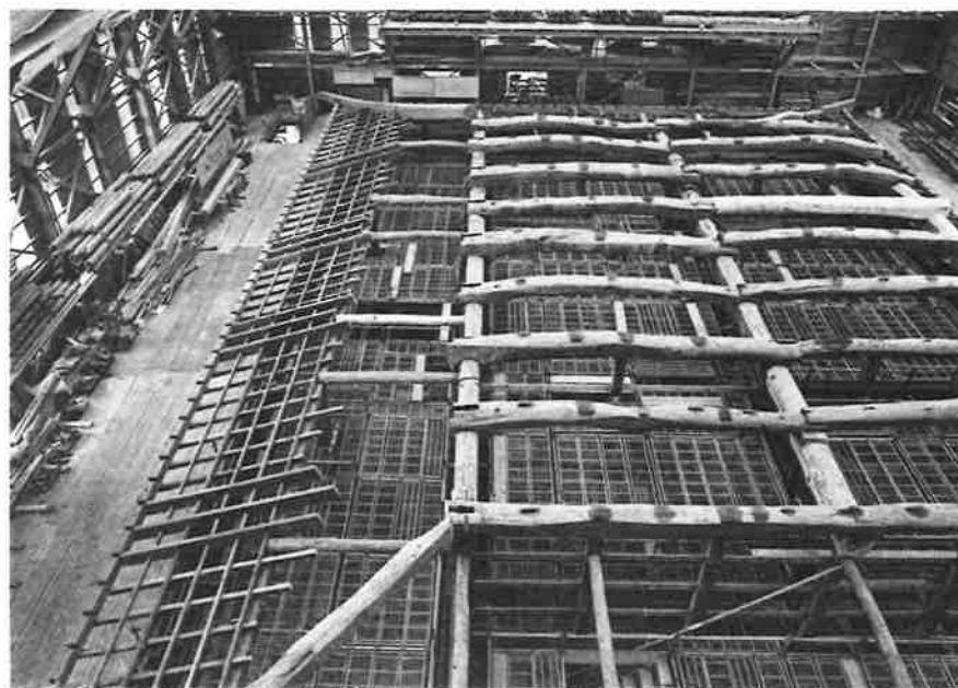
116. 地垂木・小屋梁 組立状況 北より見る
