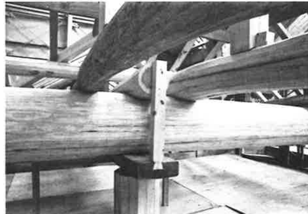
404. 輪蔵心柱の軸受取付詳細 残存する仕口及び釘痕跡に倣い、取り付けた
