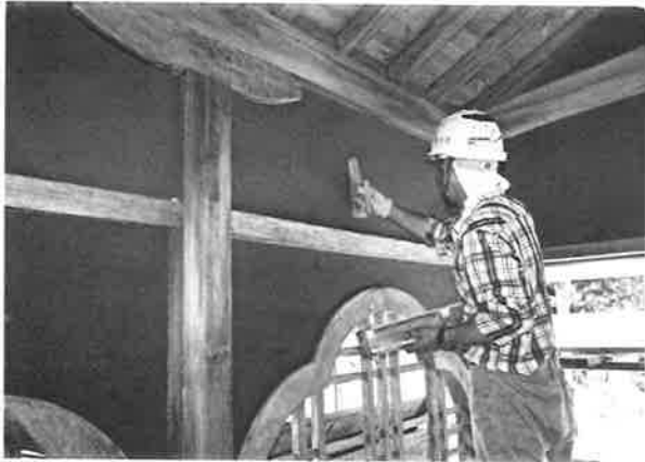
199. 南面廊下 中塗施工状況
