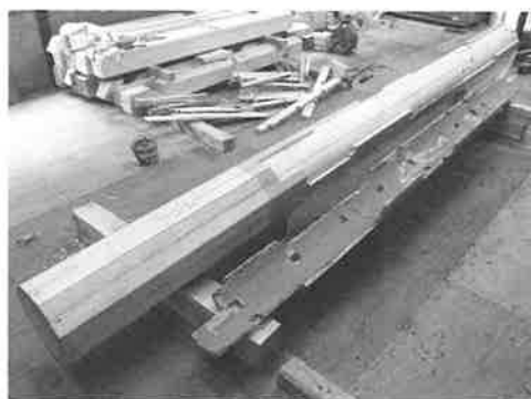
写真4-49 輪藏心柱補修状況
