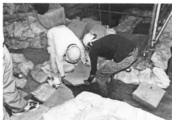
390. 主体部北西隅部分の礎石据え直し状況
