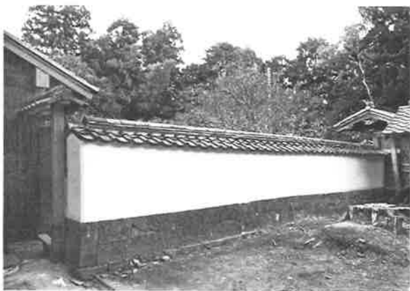
225. 土塀 復旧完了
