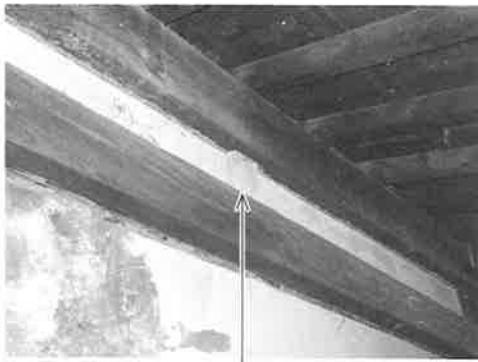
写真4-9 垂木掛け下の柱仕口。有壁長押には無い
