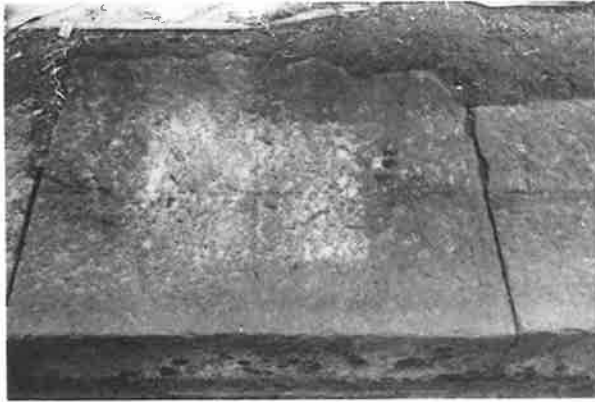
261. 正面（東）礎石上端の残存墨状況 通墨と番付が残っていた
