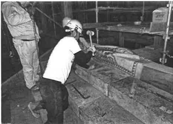
139. 正面 (東) 石段据付状況
