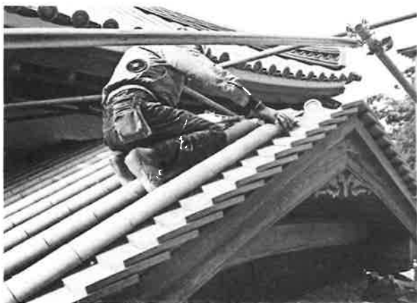
201. 南面廊下 屋根瓦葺状況
