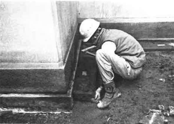
397. 周囲雨落石の据直し状況
