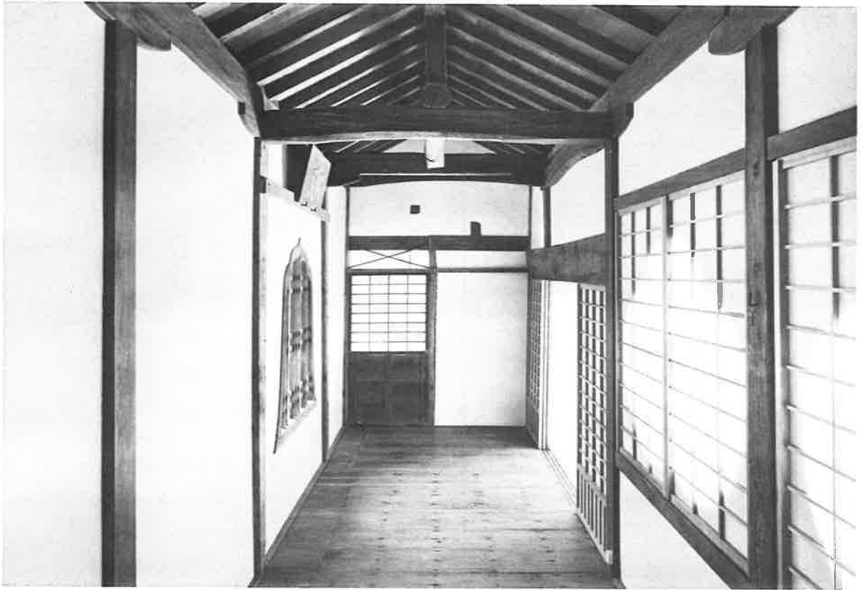
24. 竣工 北面式台玄関及び廊下（南より見る）
