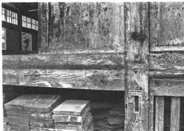
249. 同右詳細 足元の痕跡状況 廊下の床高は本堂より低く、庫裏に合わせている
