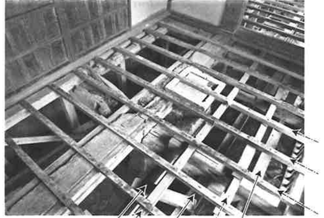
86. 要旨二 「仏間」背面（落縁）の床下状況 当初の床組が残存する
