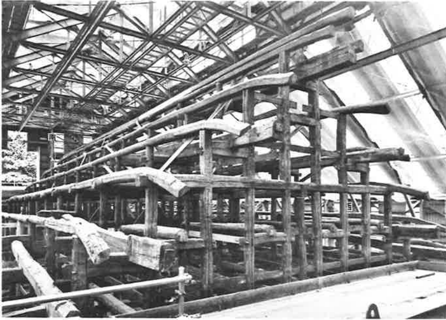
120. 小屋組 組立完了 北妻
