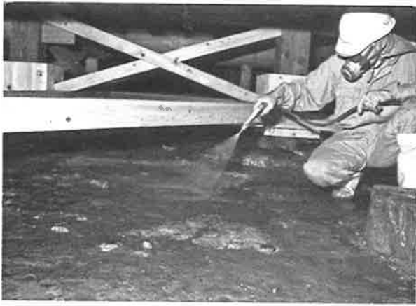
179. 床下土壌処理状況
