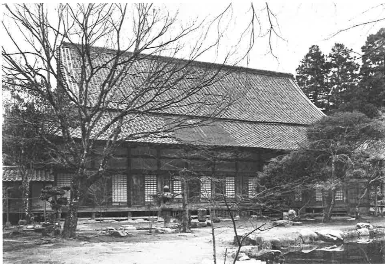
30. 修理前 背面（西）
