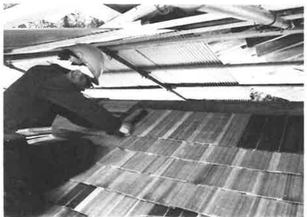
200. 南面廊下 土居葺施工状況
