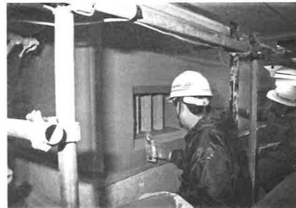
420. 外壁 鼠漆喰塗施工状況
