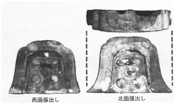
355. 経蔵 要旨一 (二) 残存鬼瓦状況 北面張出しの鬼瓦天端には鳥衾の決りがある
