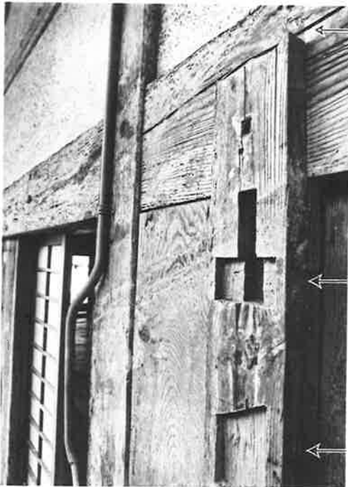
257. 同右 半柱痕跡詳細 桁の痕跡が現状の他、二期認められる。当初桁は半柱天端に置かれる
