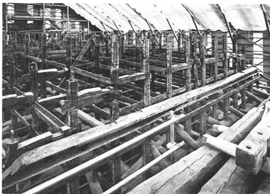
64. 二重小屋梁、虹梁解体完了 北妻
