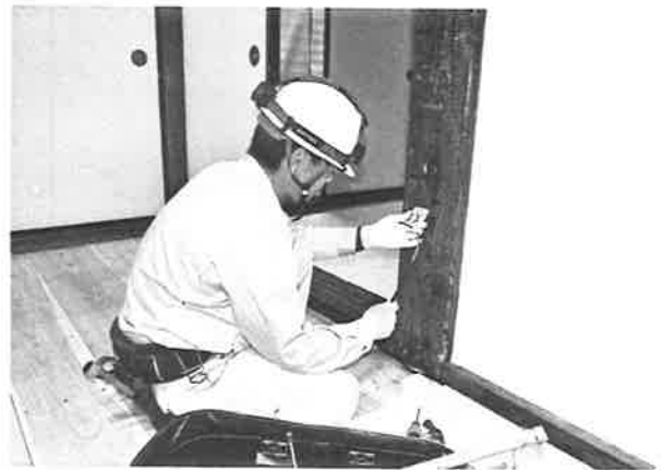
182. 電気設備施工状況
