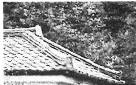
356. 経蔵 要旨一 (二) 古写真部分 (山口県文書館所蔵) 北面張出し屋根 隅棟には鬼が取付いていた
