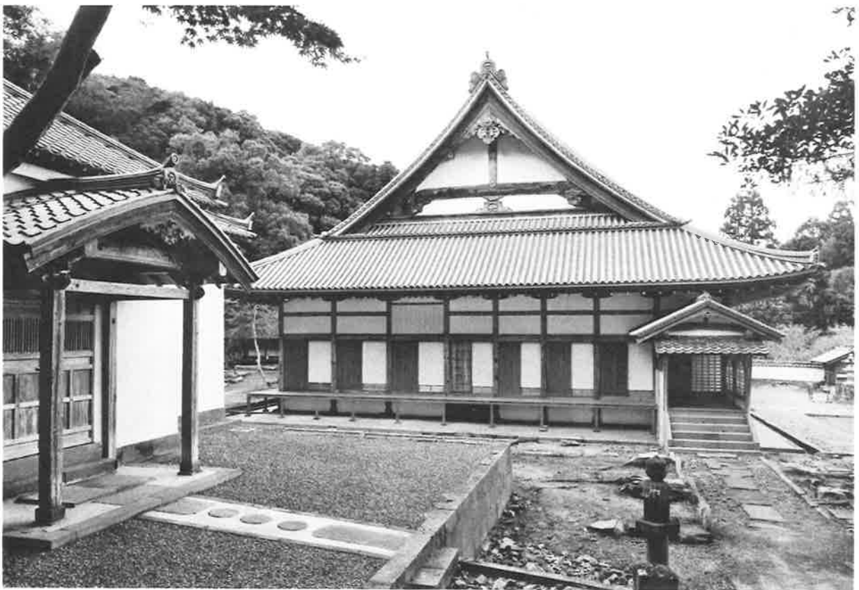
321. 経蔵及び本堂（南より見る）
