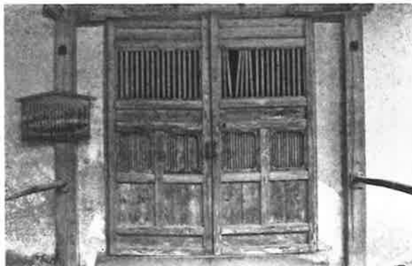
357. 経蔵 要旨二 棧唐戸修理前 羽目板の中棧から上が、格子に変えられている
