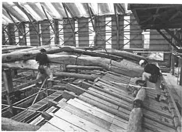
147. 登梁据付状況
