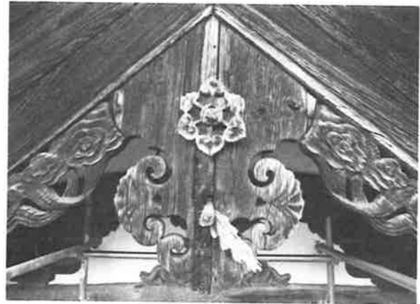
110. 要旨八 類例 大照院庫裏 東妻の懸魚 六葉の下には植物飾りの彫刻が取り付けられている。痕跡から、以前は葉が三枚取付いていた
