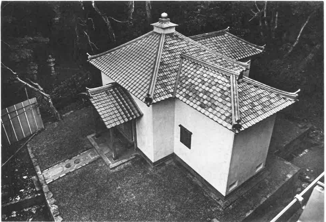
320. 竣工 屋根の状況（北東より見る）
