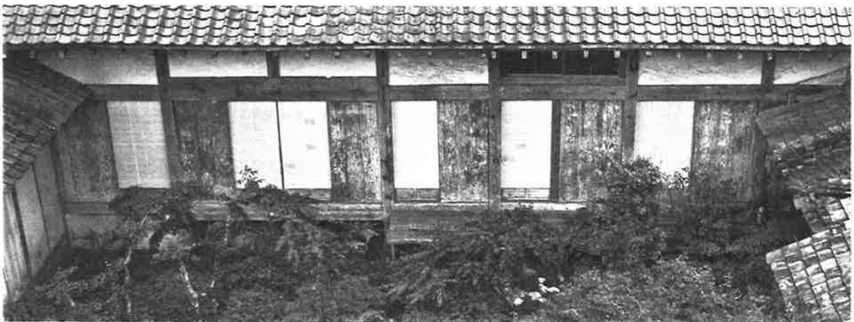
96. 要旨五 古写真部分(萩博物館所蔵 昭和中期頃)北面濡縁部 二間の開口部には、庫裏への渡り廊下がり取り付いていたため、濡縁はない
