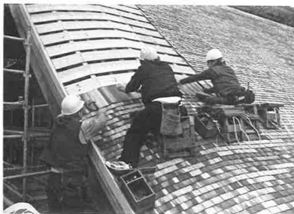
151. 土居葺施工状況
