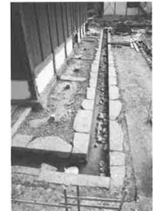
【写真5】南区 遺構検出 (西から)
