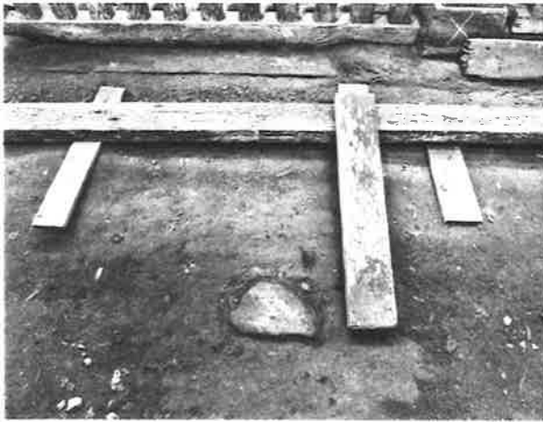
95. 要旨五 北面濡縁の痕跡 保管材に、現状の石や痕跡と配置の合う縁葛及び縁束が発見され、痕跡から当初とみられる
