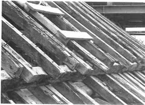
245. 東面上屋野垂木の鼻先 当初の垂木鼻及び瓦座は敷桁と同一面であったが、明治初年の修理時に、正背面に補足した上屋垂木鼻を当初垂木より前に引き出した。鍍葺の取り合いに、雨仕舞の対策を講じたと思われる
