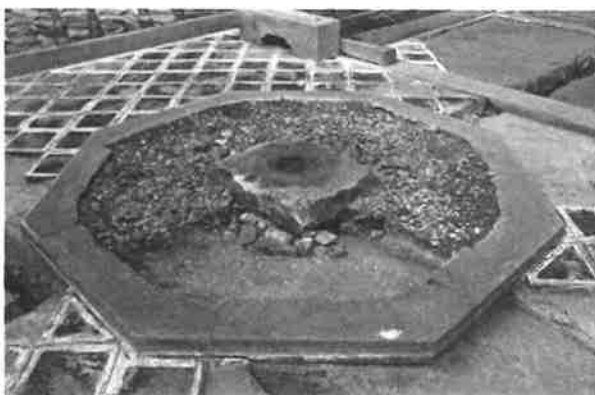
459. 輪蔵基礎の状況 台座基礎の根入れはほとんどないが、心柱礎石は造成地盤面をやや掘り込んで、栗石を敷いた上に据えていた
