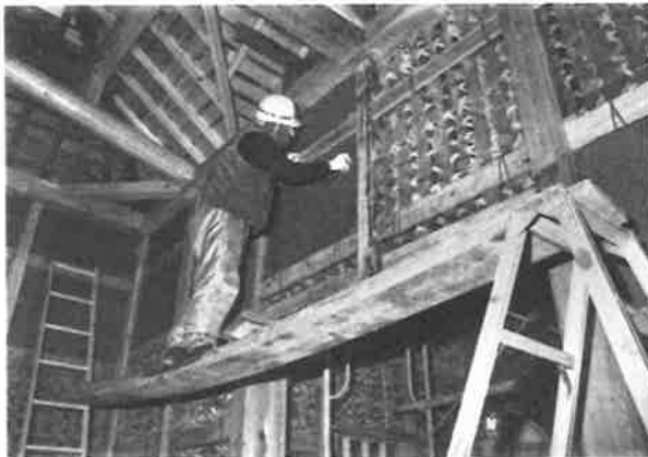
419. 構造補強壁施工状況 外壁(大壁)と内壁(真壁)の間を土で充填し、 壁の一体化を図る
