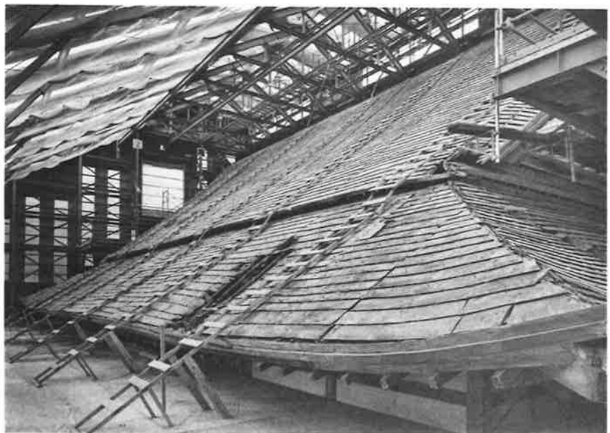
56. 土居葺解体完了 東面 北東よりみる
