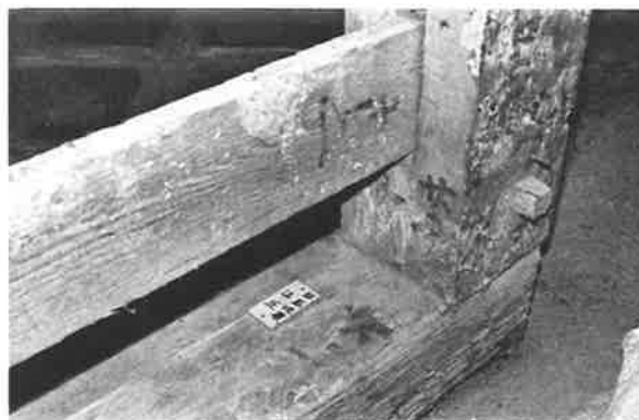
522. 経蔵 主体部 軸部番付状況 柱、土台、貫に番付が打たれている (廿二)
