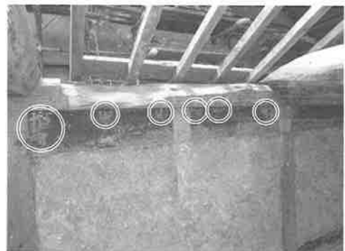
写真4-42 桁下の壁穴 ここに縄を通して桁を吊ったものと思われる
