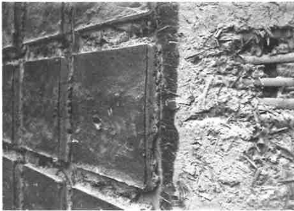
294. 同右詳細 (下地骨解体後)
