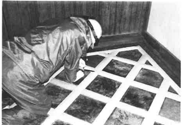
394. 四半敷目地漆喰施工状況
