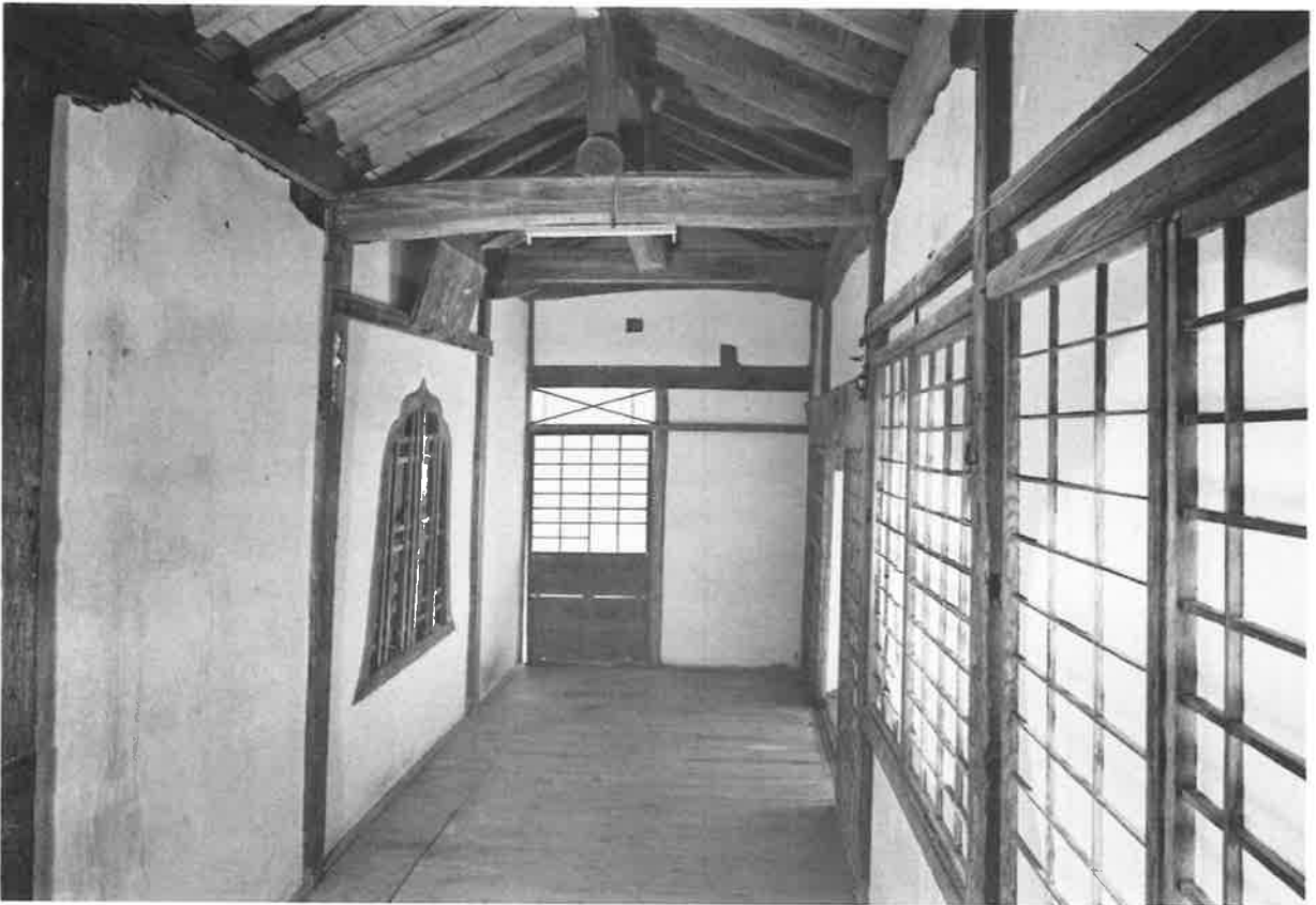
49. 修理前 北面式台玄関及び廊下（南より見る）
