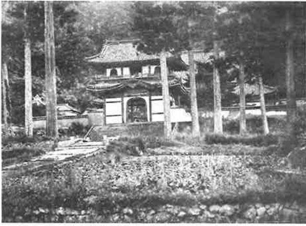
489. 同右拡大 本堂（本瓦葺）及び経蔵（棧瓦葺）が写る。鐘楼門上層は棧瓦葺としている
