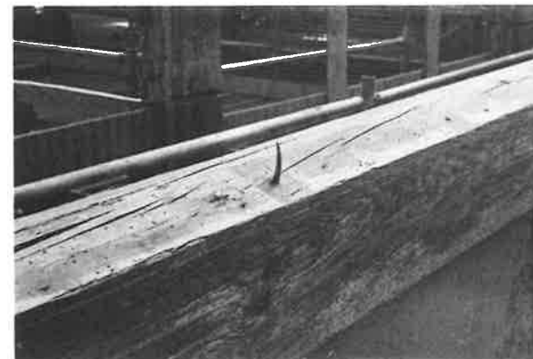
267. 地垂木止釘 合釘の状況 力垂木を除く地垂木は、垂木勾配に対して直角 方向に打った合釘で、丸桁上に止める
