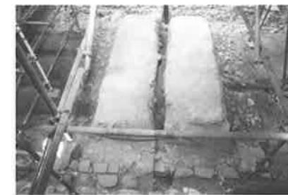
【写真26】同上 基礎土盛土前の礎地業A (北から)
