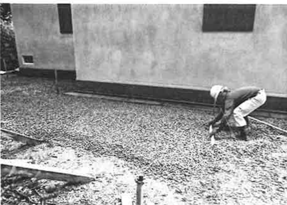
399. 周囲砂利敷施工状況
