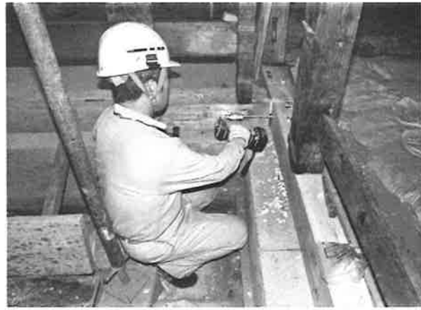
402. 構造補強状況
