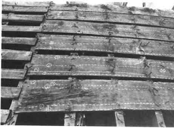
243. 背面南端の棟際 野地板の状況 当初野地板が一部残存していた。この他、背面北端の棟際及び北面上屋に残存する。当初野地板の釘痕跡から、当初含め六回程の土居葺のやり替えが確認された。残存する当初野地板は幅広板の目透かし張りとする
