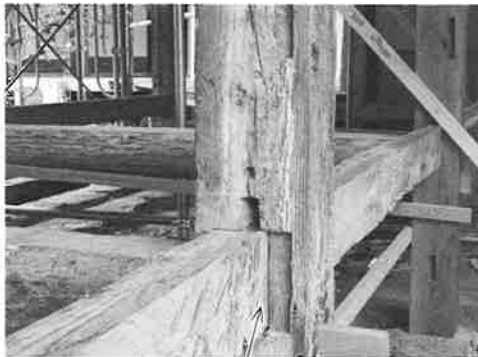
写真4-8 表面を斫り取られた足固と柱に残る仕口
