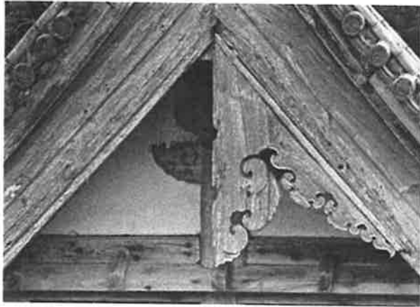
109. 要旨八 古写真部分（萩博物館所蔵 昭和中期頃）北妻懸魚 中心部に仕口が二箇所認められる
