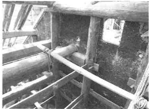
写真4-38 小屋内に残る丸太 (写真は南妻)
