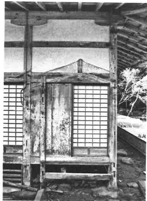
256. 書院廊り廊下解体後の痕跡 北より本堂を見る
