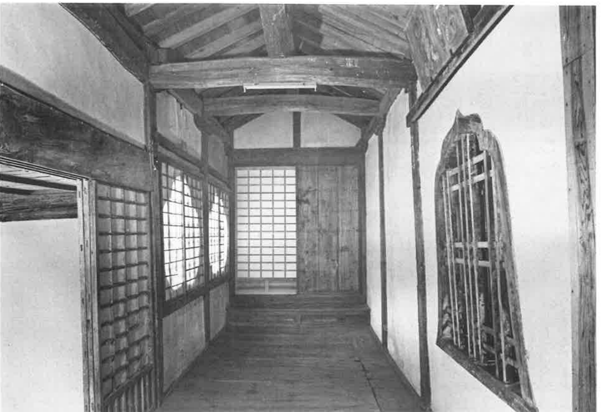
50. 修理前 北面式台玄関及び廊下（北より見る）
