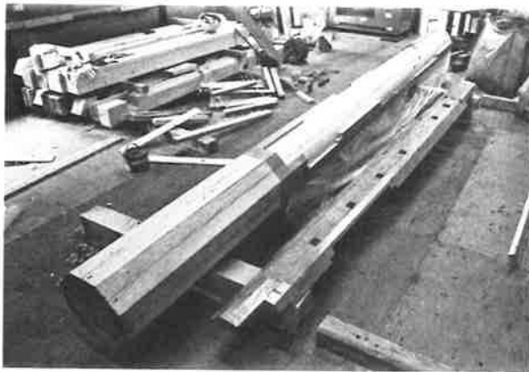
427. 輪蔵 心柱加工状況 3 新規の心柱を、残存した古材に合わせて加工した
