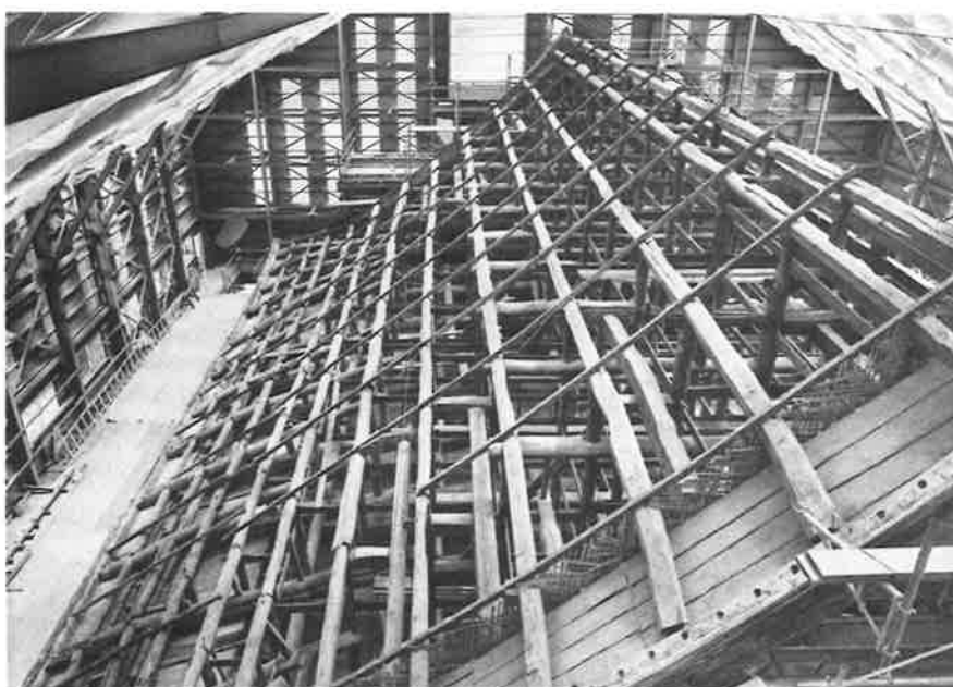
61. 同上 東面 北より見る
