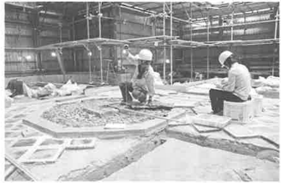
【写真30】 経石取り上げ作業（南東から）
