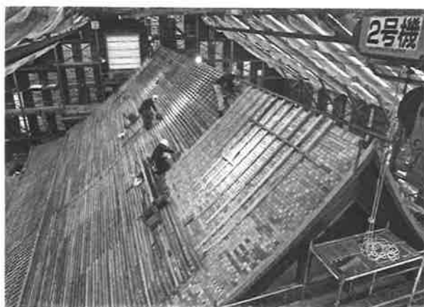
153. 瓦棧取付状況
