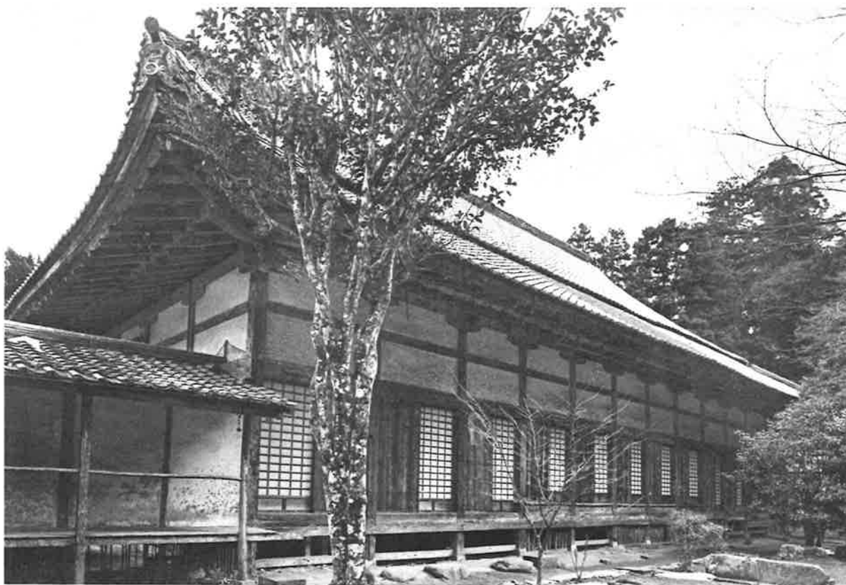
31. 修理前 背側面（北西より見る）
