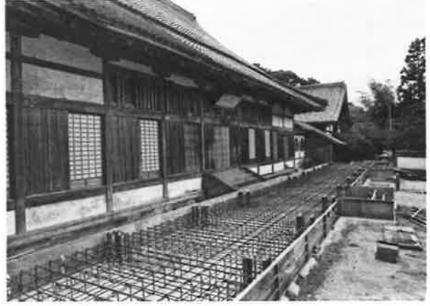
202. 本堂 素屋根基礎 配筋状況
