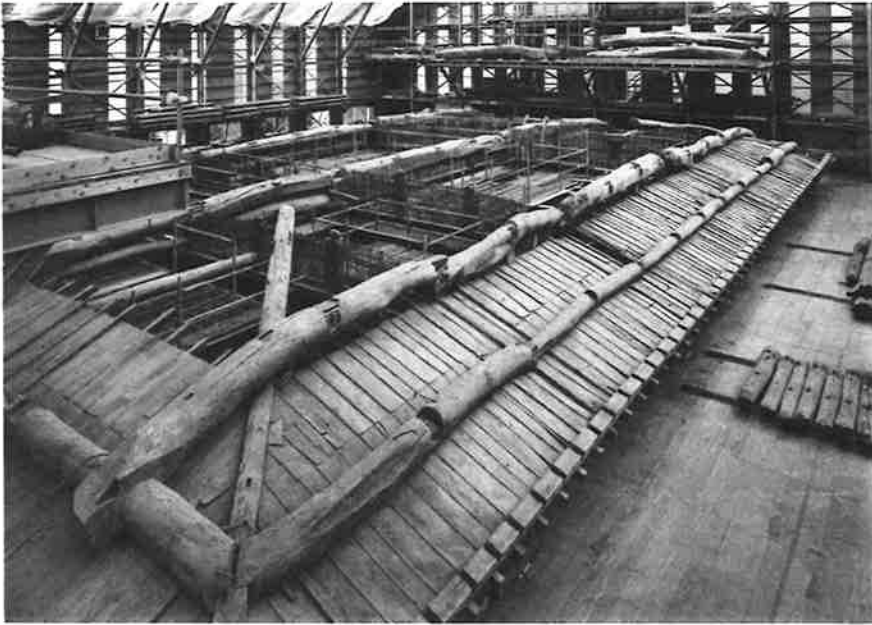
69. 飛檐垂木・小屋梁解体完了 西面 北西より見る
