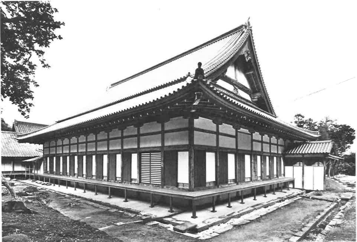
5. 竣工 背側面（南西より見る）
