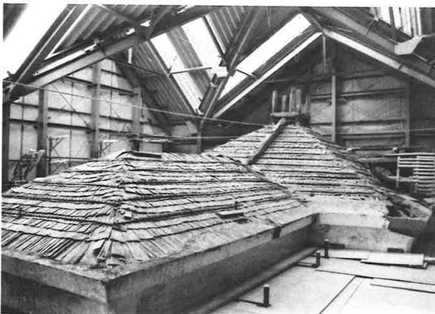
340. 本体屋根 土居葺状況 北西より見る
