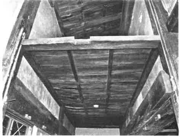
92. 要旨三 天井廻縁(中古)にあるトコの間痕跡 トコの柱欠込みがある
