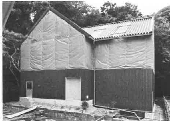
207. 経蔵 素屋根建設完了
