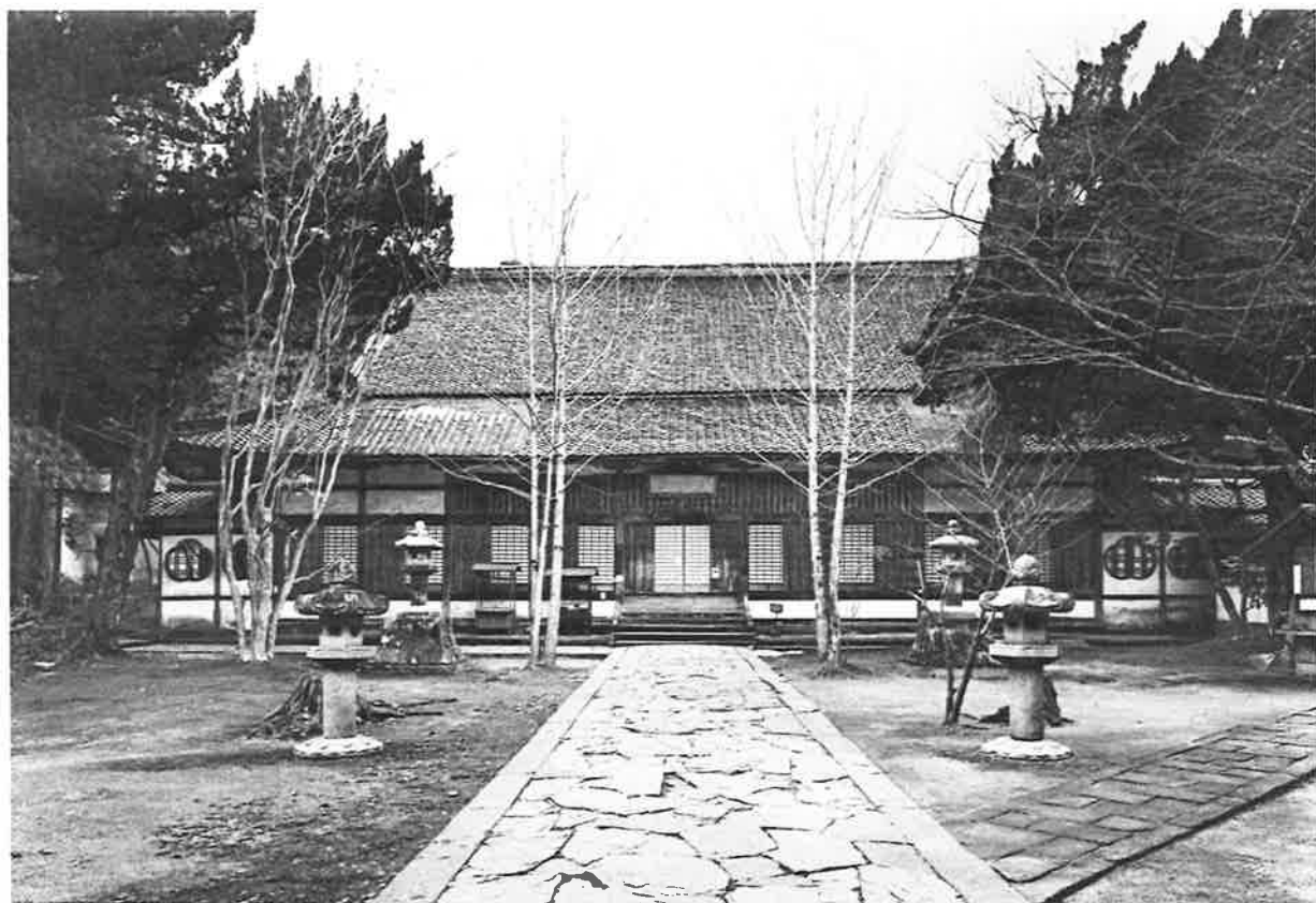
26. 修理前 正面（東）
