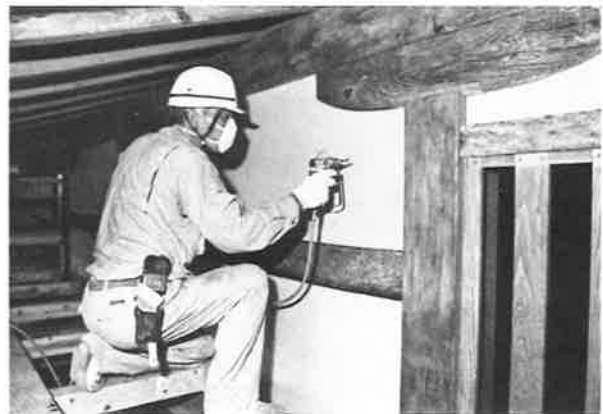
190. 外壁撥水処理状況
