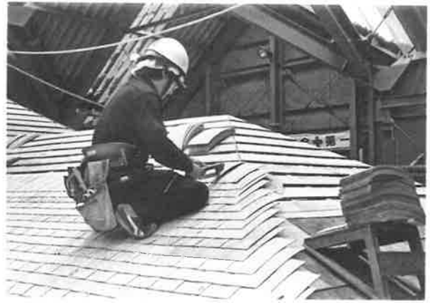
408. 置屋根 土居葺状況 機械割の木端板を使用した
