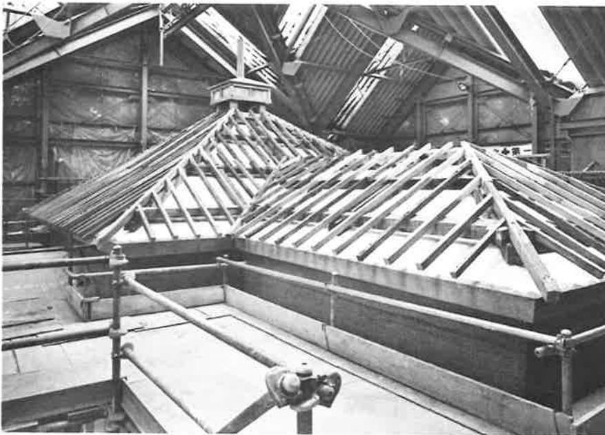
372. 置屋根 垂木組立完了 北東より見る
