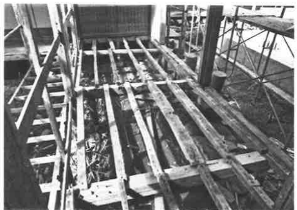
216. 書院渡り廊下 床組の状況 南より見る
