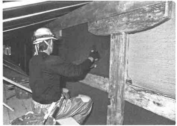
162. 外壁中塗施工状況
