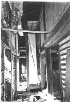
497. 南より見る トコ解体中
