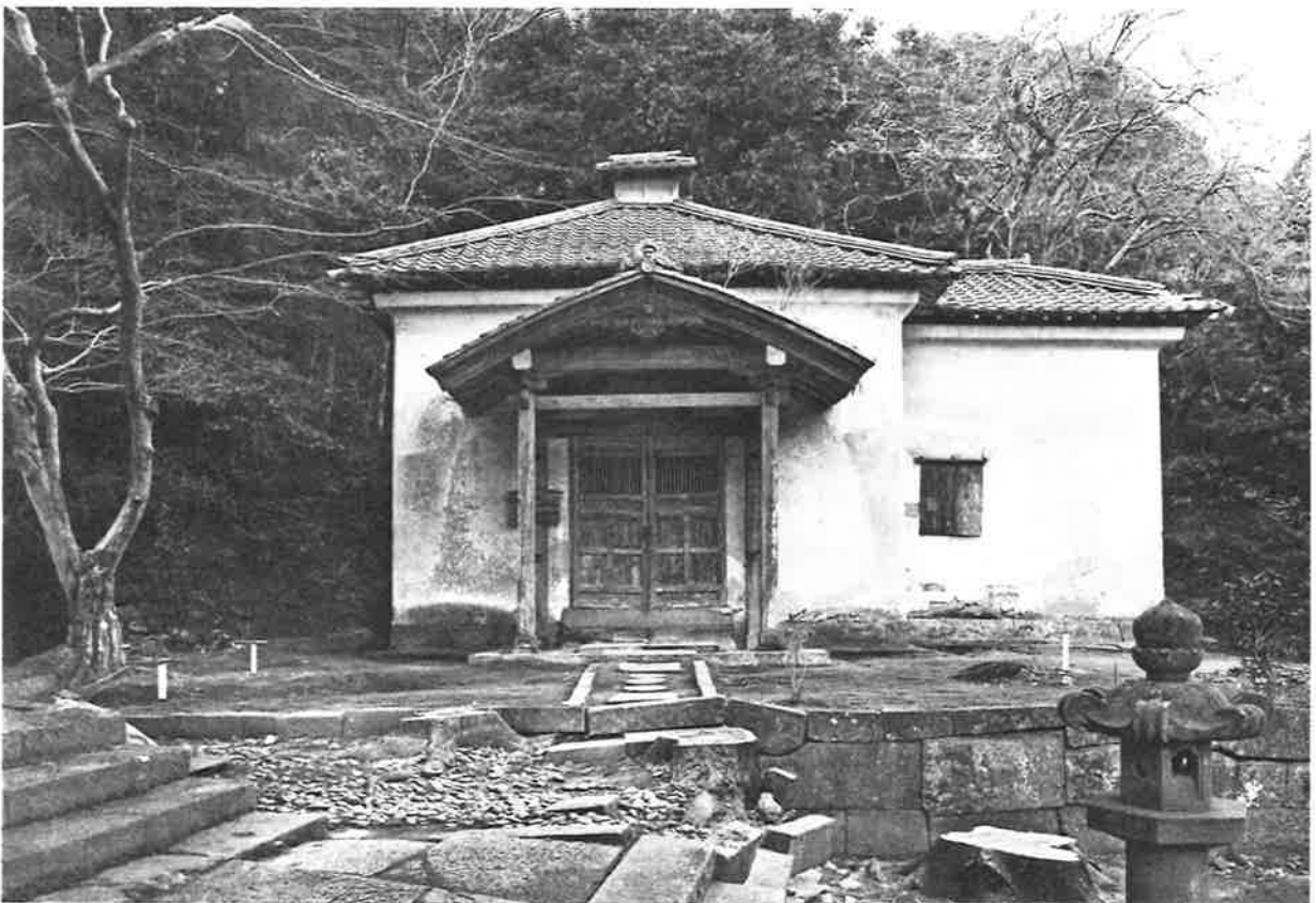
329. 修理前 正面（東より見る）
