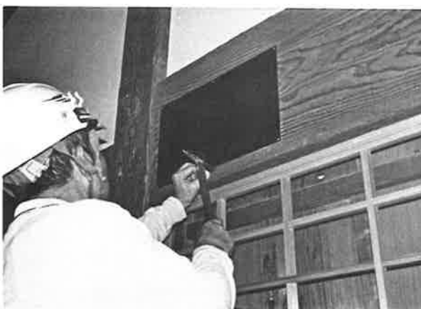
185. 修理銘板取付状況
