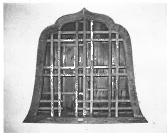
307. 北面式台玄関火頭窓の状況
