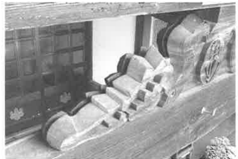
写真4-34 善福寺庫裏 玄関の墓股 足の形状が良く似ている。この墓 股も転用材で、上端に板溝がある
