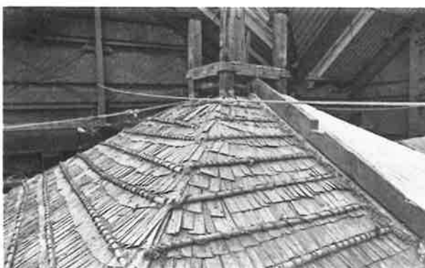
461. 主体部本体屋根 土居葺の状況 木端板はマツ材としていた
