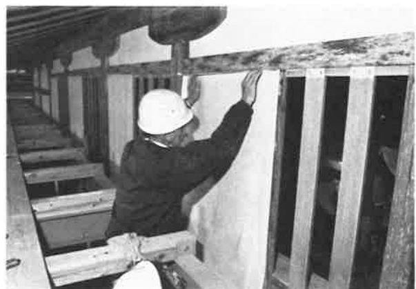
192. 平格子窓 紙貼り施工状況
