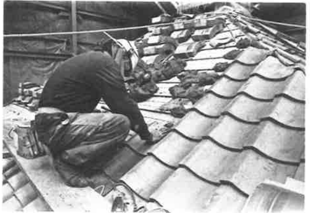
410. 棧瓦施工状況 棧瓦は全て昭和52年頃修理時の新しいもので、軒棧瓦は新調し、その他の健全な瓦は極力再利用した
