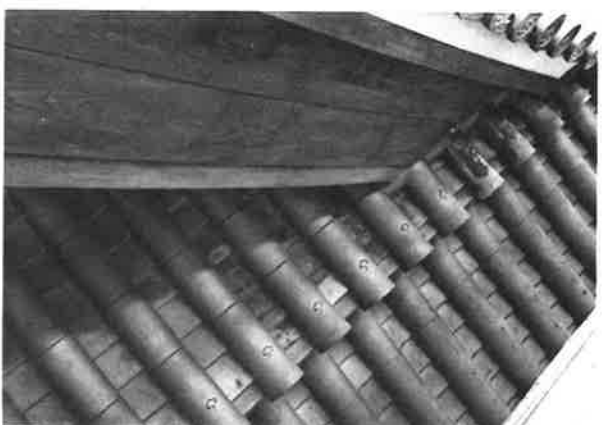
160. 北面西側の瓦葺状況 破風下部分に一部、旧瓦を再利用した
