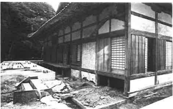
315. 南面廊下 解体完了
