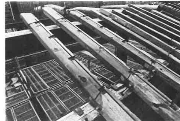
266. 地垂木 力垂木の仕口状況 側桁上は太柄を入れ、入側桁上は垂木の両脇か ら釘止めとしている
