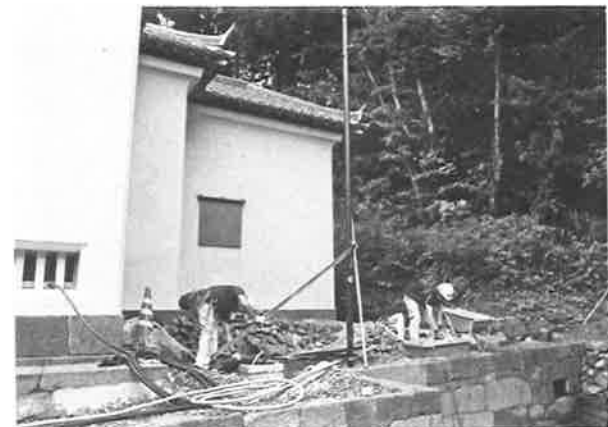
446. 電気設備設置状況
