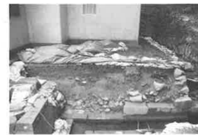
【写真20】同左 背面裏込土16 (北から)
