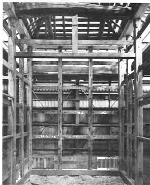
379. 西面張出し 軸部組立完了
