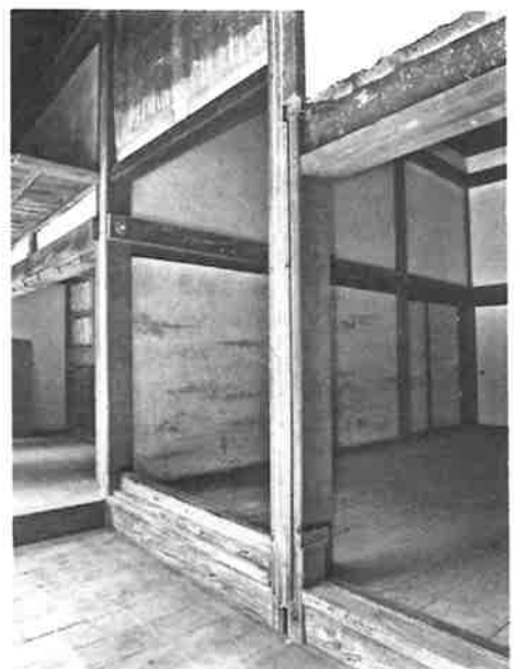
90. 要旨三 トコ・書院の痕跡 現状ベニヤ壁の撤去状況
