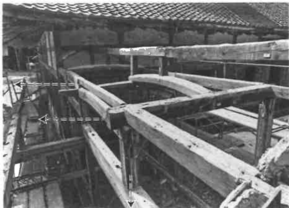
柱が切断され、差鴨居が補足された
