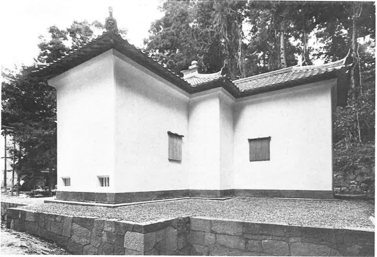
318. 竣工 背側面（北西より見る）
