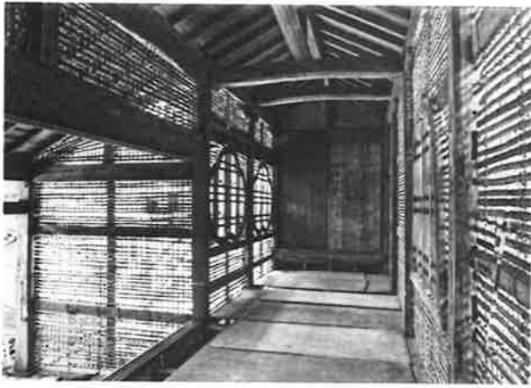
195. 北面式台玄関及び廊下 小舞掻施工状況
