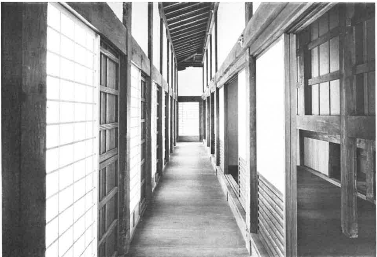
20. 竣工 西落縁及び「仏間」後方（南より見る）
