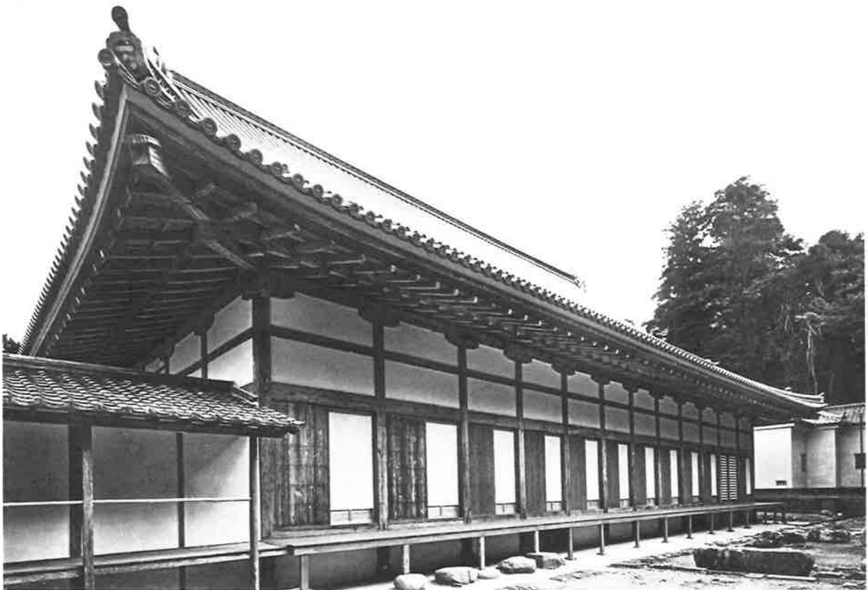
6. 竣工 背側面（北西より見る）
