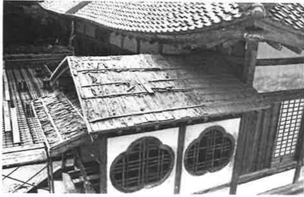
309. 南面廊下 東面 土居葺状況 本堂から一間分は木端葺で、当初の土居葺が残存していた
