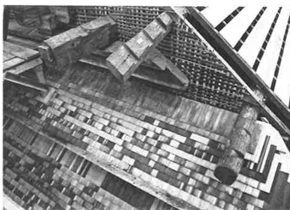
152. 北面西側の土居葺状況 妻壁の際に一部、古材を再用した
