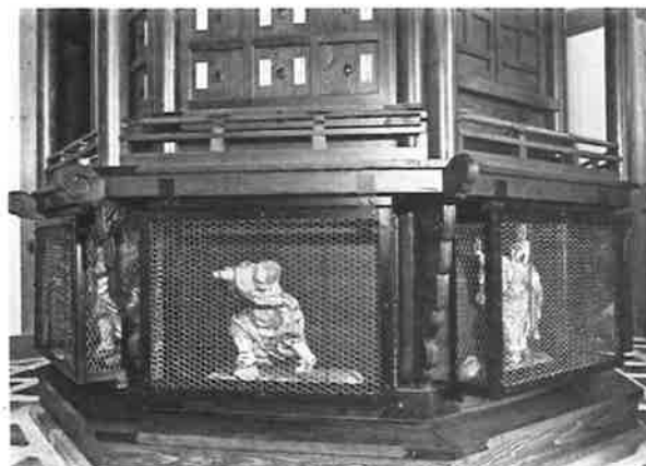
447. 輪蔵 八天像保護柵設置状況
