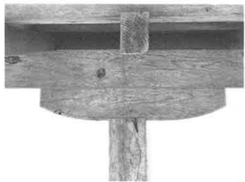
写真4-15 柱からの出が左右で違う舟肘木
