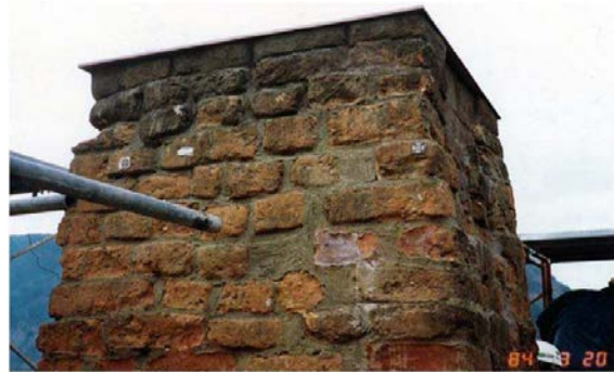
写真 2-42 昭和 58 年 (1983) 度 セメントモルタル充填後
