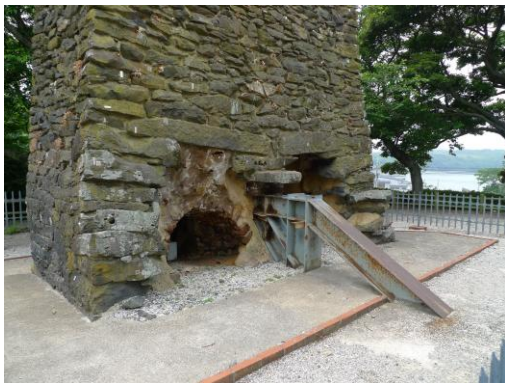
写真 2-7 炉北面、補強鉄骨材
