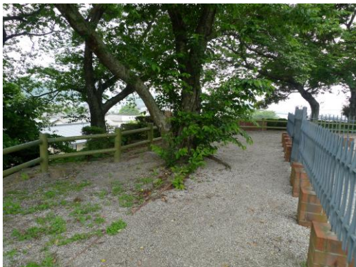
写真 2-15 反射炉本体周辺縁石を持ち上げるサクラ
