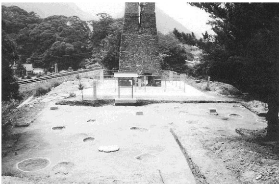
写真 2-22 反射炉北側建物写真 (昭和 59 年 (1984) 度 北から)
