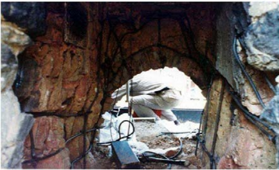
写真 2-41 昭和 56 年 (1981) 度 アーチ部補修 (鉄筋下地)
