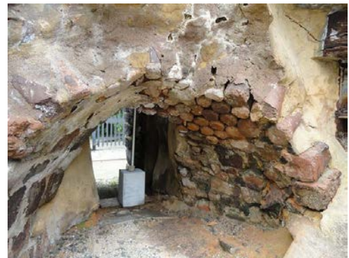
写真 2-8 炉天井 円柱状煉瓦
