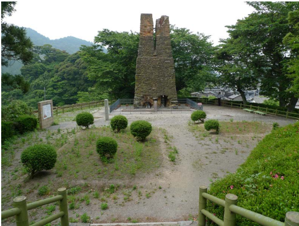
写真 2-2 反射炉本体全景（北面から）
