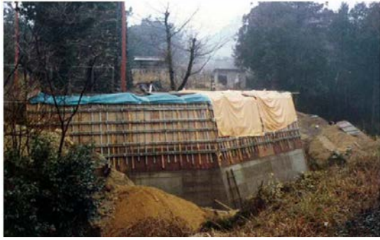
写真 2-39 昭和 54 年 (1979) 度 擁壁工事
