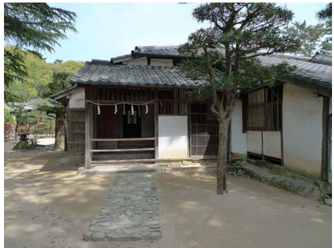
写真 2-7 吉田松陰幽囚ノ旧宅西面 式台玄関
