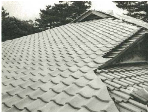
棧瓦葺施工状態(東面)
