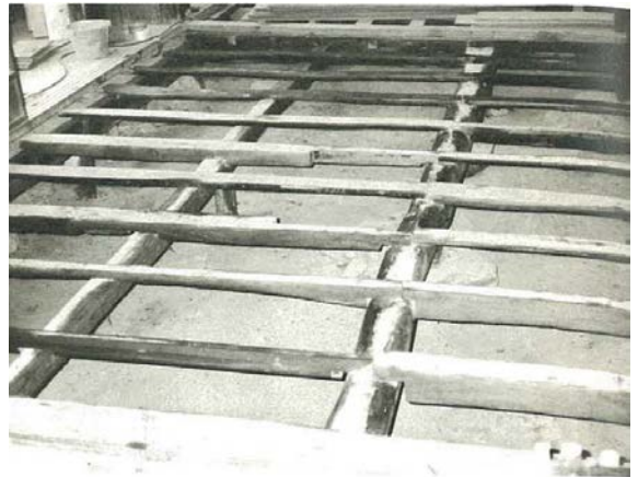
大引、根太の補修、キシラモン塗布
