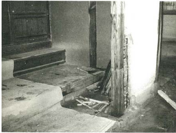
式台玄関の南柱根継状態
