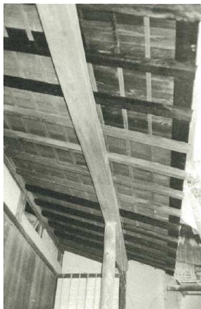
北庇の軒補修状態
