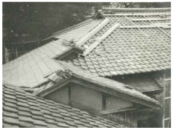
棧瓦葺施工状態(南西面)
