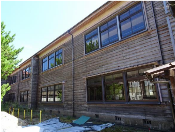
旧明倫小学校校舎(2号館、3号館、4号館) (14)
