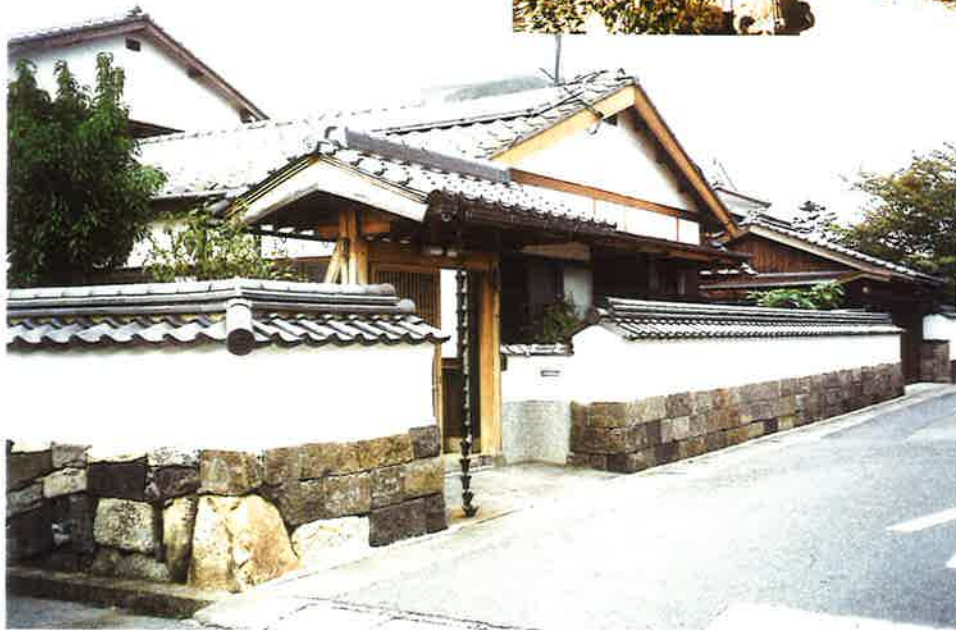
修理した 土塀・門 （堀内地区）
