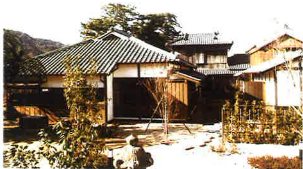
修理した 旧田中別邸 （平安古地区）
