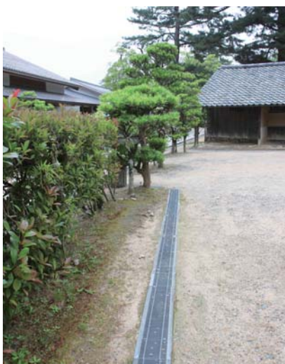
写真⑲ 排水施設
