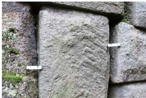
石垣の目地の開きモニタリング実施事例 (史跡金沢城跡)
