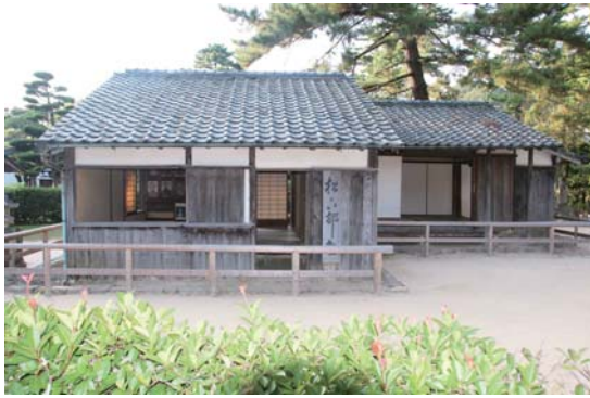
写真① 松下村塾全景（南面）
