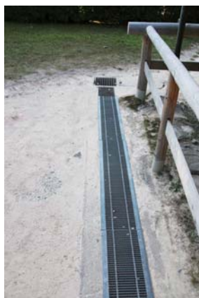
写真⑥ 排水施設
