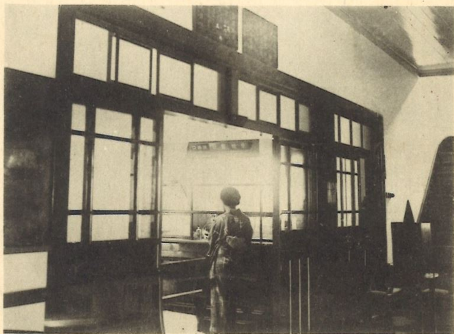
萩町玉木病院本館正面
