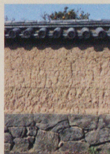
山石の基礎を用いた本瓦葺き土堀
