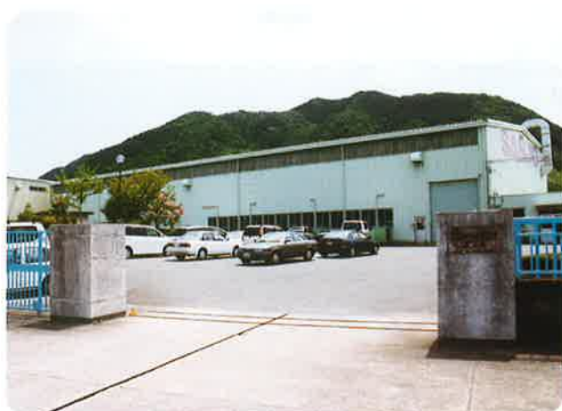
きかいの工場
