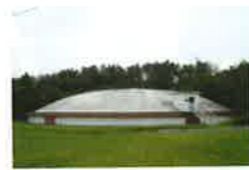
上野配水池 各家庭に配水を行うために、浄水を一時たくわえるしせつ
