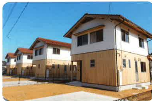
どうぶらいきていじゅうそくしんじゅうたく すきじゅうたく 萩市東部地域定住促進住宅「うみかぜ須佐住宅」
