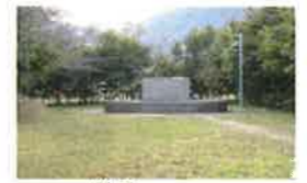
原水を取り入れるためのしせつ
