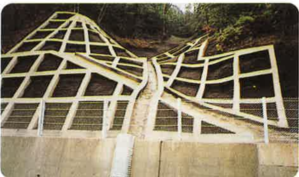
平成9年がけくずれ改しゅう工事 かい
