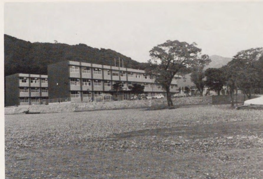
椿東小完成写真
