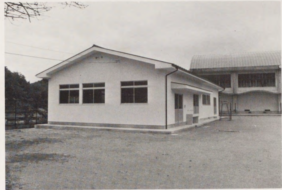
大井中技術科教室外部
