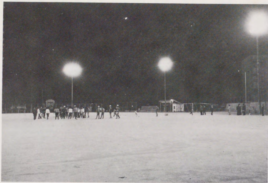
椿東小屋外照明施設
