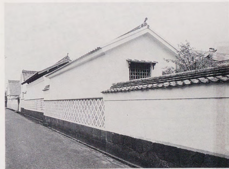
菊屋家住宅養蚕場(ナマコ壁等を仕上げ竣工)
