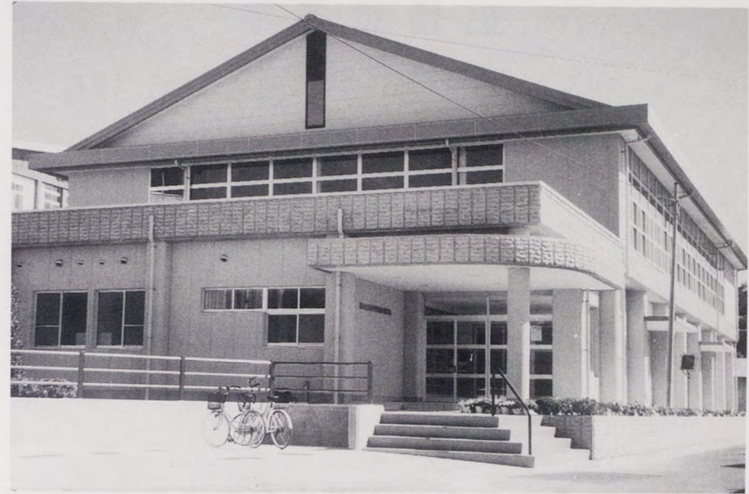
見島中学校屋内運動場
