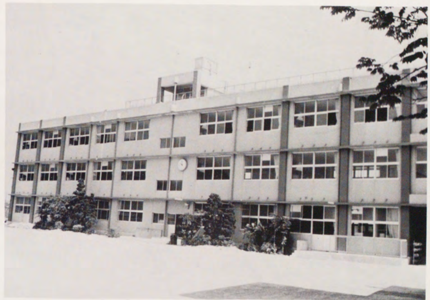
大井小学校校舎
