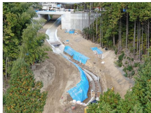
■施工状況（令和2年11月）
