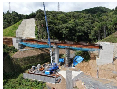
■架設状況（令和3年8月）
