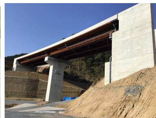
■完成状況（令和4年2月）
