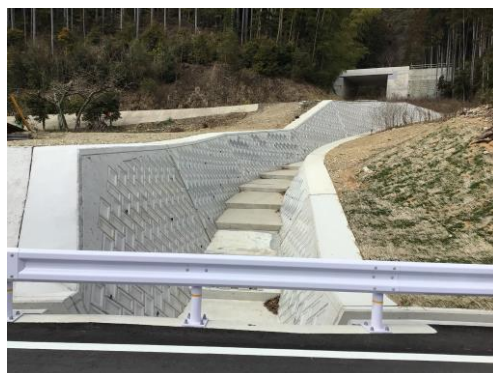
■完成状況（令和4年3月）
