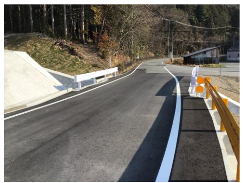
■完成状況（令和4年3月）
