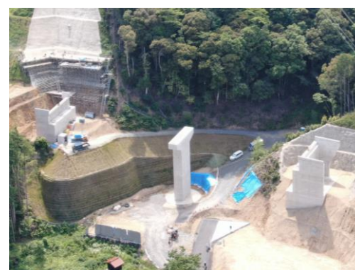
■下部工完成状況（令和3年5月）
